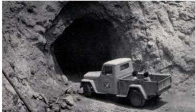
Túnel número 4. Perforado en arenisca compacta. Diámetro de la boca: 4.40 m. Longitud: 200 m. Pendiente: 0.0012. Capacidad: 17 metros cúbicos por segundo.
