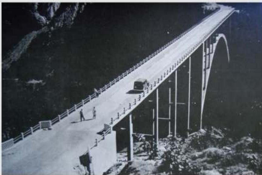
*Puente Barranca Honda en el camino Uruapan-Apatzingán, bajo su carpeta se aloja el Sifón que conduce las aguas del río Cupatitzio. Diámetro 2.3 m. de longitud, 348 m. de capacidad, 20 m<sup>3</sup>/seg.*
