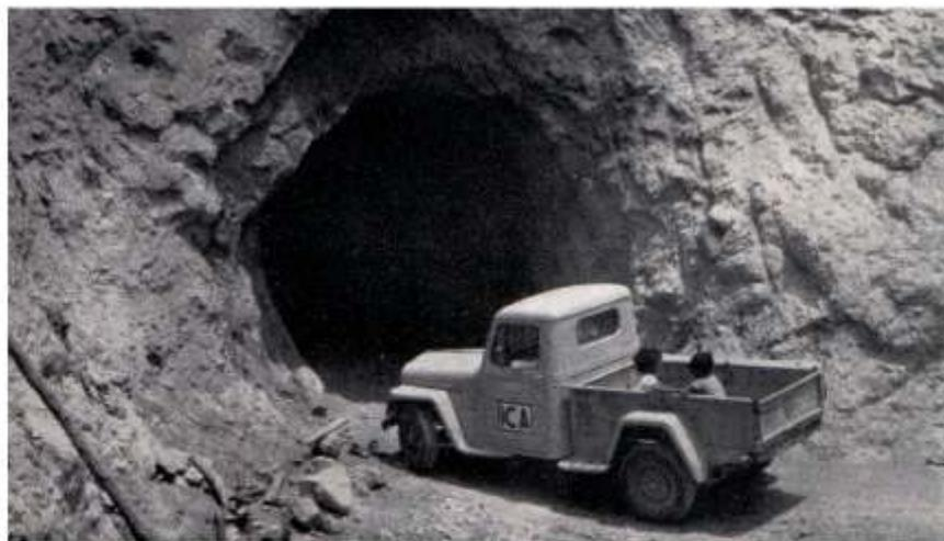
Túnel número 4. Perforado en arenisca compacta. Diámetro de la línea B: 4.40 m. Longitud: 390 m. Pendiente: 0.0012 Capacidad: 17 metros cúbicos por segundo.
