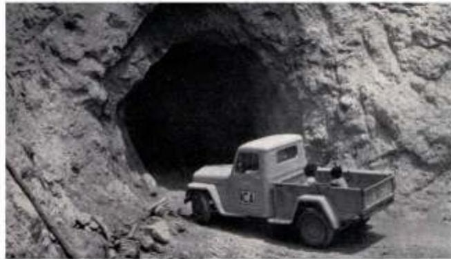
Túnel número 4. Perforado en arenisca compacta. Diámetro de la línea B: 4.40 m. Longitud: 290 m. Pendiente: 0.0012. Capacidad: 17 metros cúbicos por segundo.
