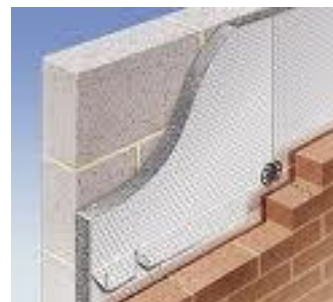
Fig. 47. Modo de Empleo del Poliestireno
