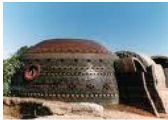
Fig. 84. Casa de Tierra
