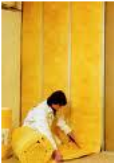
Fig. 44. Instalación de Lana de Vidrio
