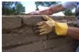
Fig. 5 Muro de Adobe
