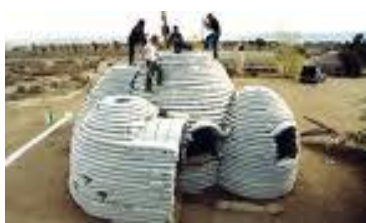
Fig. 11 Casa de Textil relleno de Tierra
