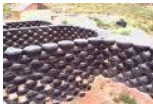
Fig. 98. Muro de LLanta
