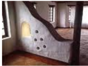
Fig. 86. Muros Interiores hechos de tierra
