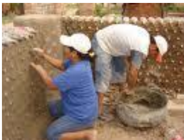
Fig. 17 Muros de Embases de Plástico Fig. 18 Casa Echa de Embases de Plástico
