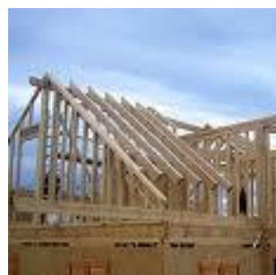
Fig. 14. Estructura de Madera
