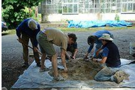
Fig. 20 La construcción con cob es una actividad altamente cooperativa
