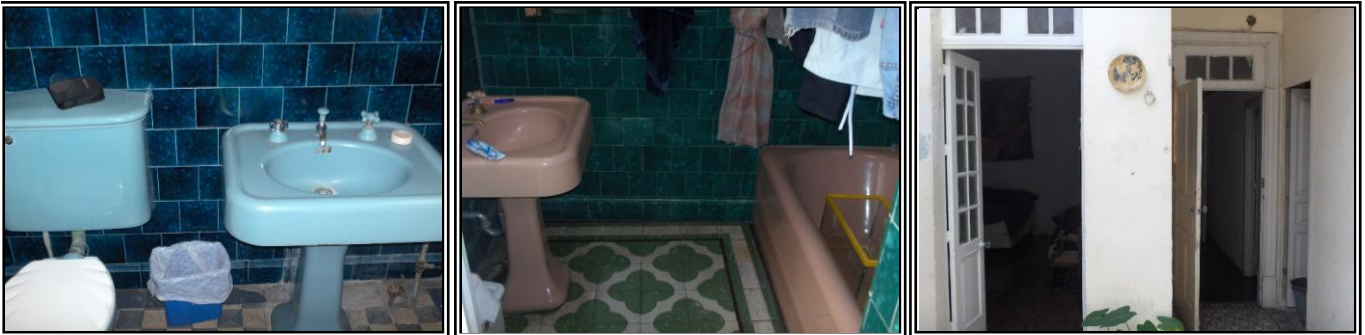
BAÑOS Y VESTIBULO
