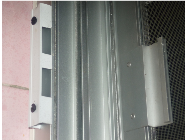
Figura 2.7. Cancelería hecha de aluminio. Se prefiere al aluminio a otros materiales por la resistencia a la corrosión que lo caracteriza.
