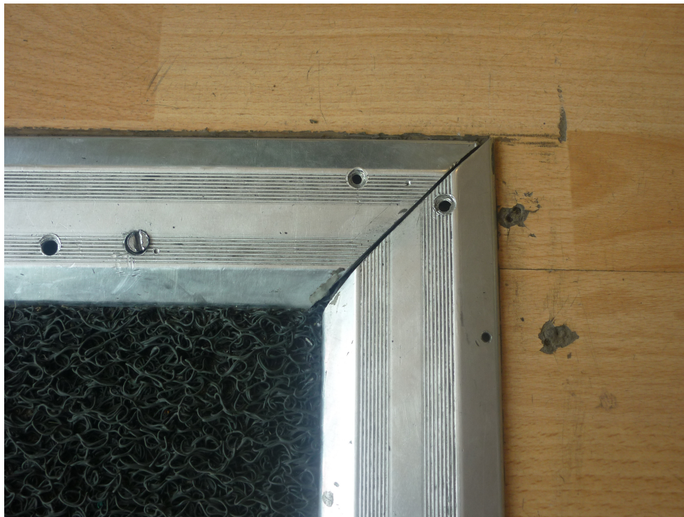
Figura 2.5. Moldura de aluminio empleada en tapicería. Estas molduras son hechas mediante extrusión.
