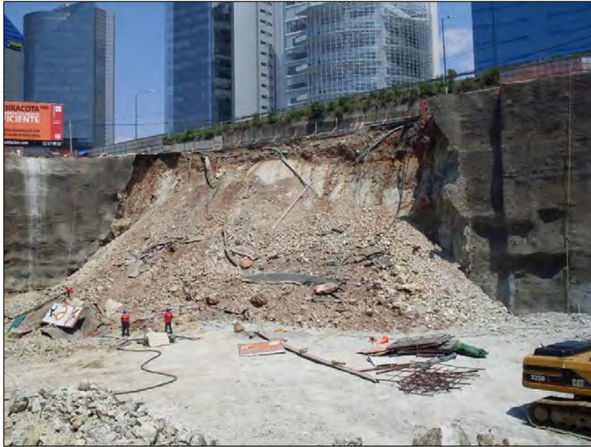
**Figura 6.50.-** Falla al interior de una excavación detonada por intensas lluvias, en la zona de Santa Fe, Delegación Cuajimalpa.
