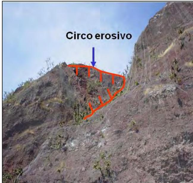
**Figura 4.7.-** Procesos de erosión en las paredes de los cortes verticales, al interior del cono volcánico.
