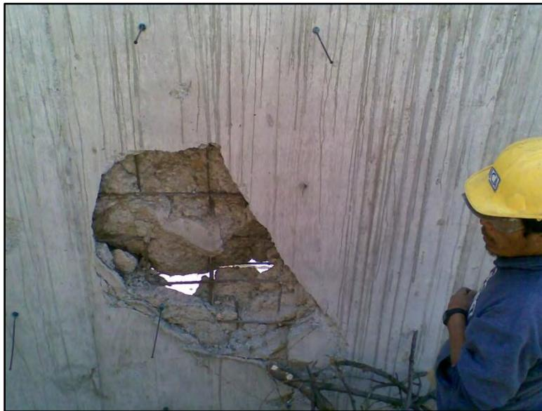
**Figura 5.17.-** Daños en el muro de concreto debido al impacto de un bloque rodado.
