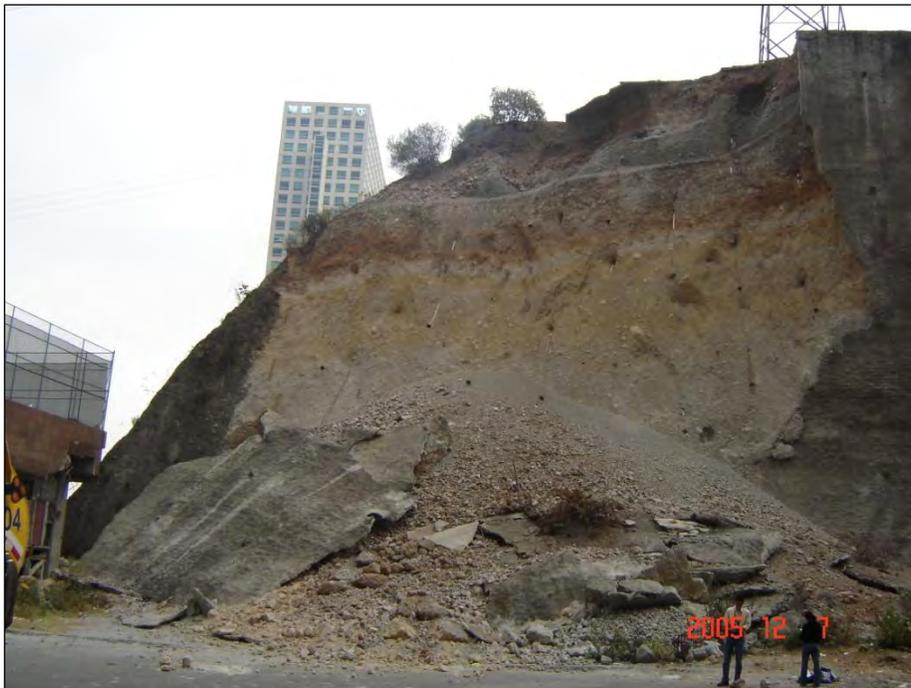
**Figura 6.49.-** Remoción en un talud formado por materiales vulcanoclásticos provenientes del volcán San Miguel. Colonia Tamarindos, zona de Santa Fe.
