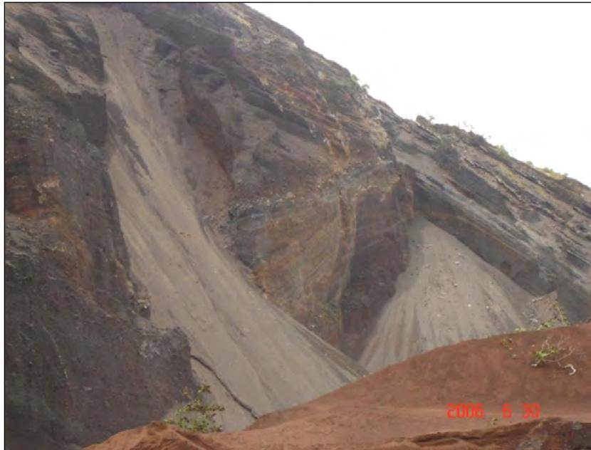
**Figura 6.18.-** Deslizamientos y flujos en cortes a cielo abierto, Sierra de Santa Catarina.
