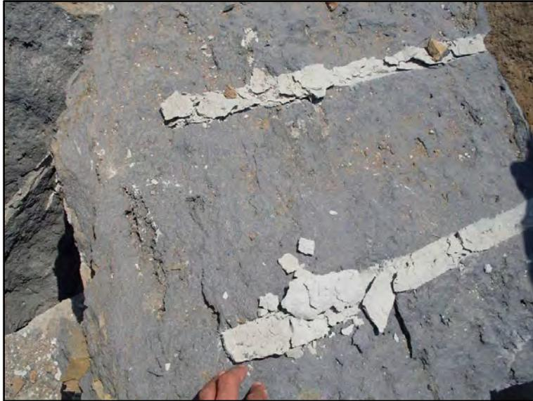
**Figura 5.22.-** Demolición controlada de bloques mediante sustancias expansivas.
