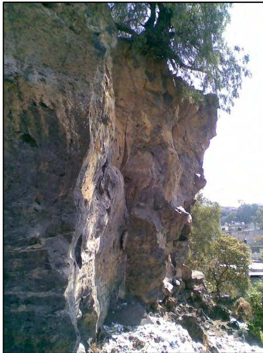
**Figura 5.15.-** Gran bloque delimitado por una discontinuidad vertical y con las raíces del árbol ejerciendo efecto de cuña.
