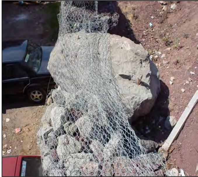
**Figura 4.11.-** Conjunto de bloques que se han desprendido sujetos por una malla tipo gallinero. Abajo se encuentra un estacionamiento.
