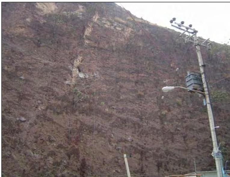
**Figura 6.19.-** Problemas de desprendimiento de bloques y detritos en cortes verticales, Cerro Peñón del Marqués.
