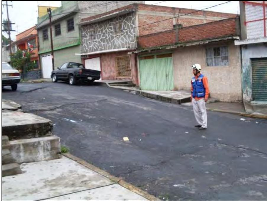
**Figura 4.19.-** Escalonamientos de hasta 1 m en el andador Nicolás Bravo, zona SE del Peñón. La entrada de agua en las grietas en temporada de lluvias, provoca desplazamientos súbitos que causan alarma entre la población.
