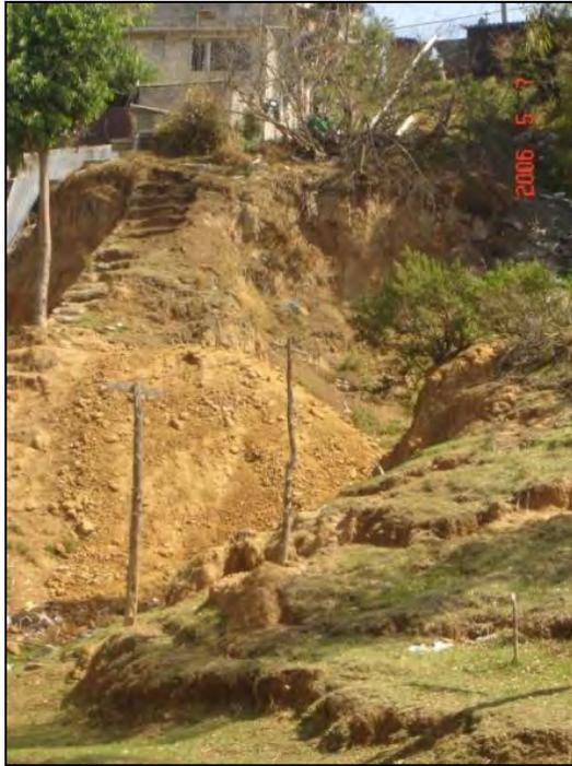
**Figura 6.25.-** Flujos de detritos y erosión en las cabeceras de los talwegs.
