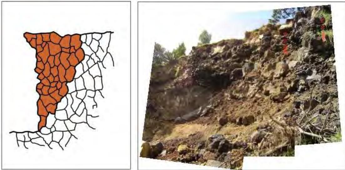
**Figura 2.15.-** Aspecto de un mecanismo complejo, con una superficie de falla irregular.
