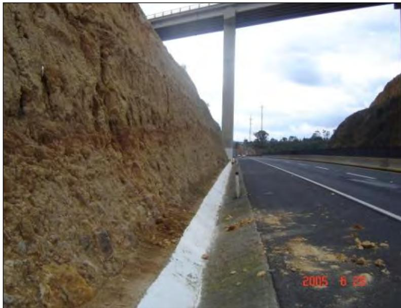
**Figura 6.24.-** Problemas de desprendimiento de detritos en depósitos vulcanoclásticos. Carretera-Chamapa-Lechería.
