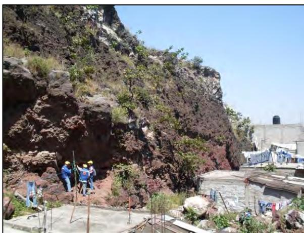
**Figura 4.27.-** Viviendas con deficientes procedimientos constructivos asentadas al pie de un talud afectado por procesos de caída de rocas.
