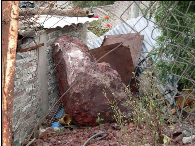
**Figura 4.13.-** Aspecto de un bloque rodado ejerciendo presión sobre el muro de una vivienda.
