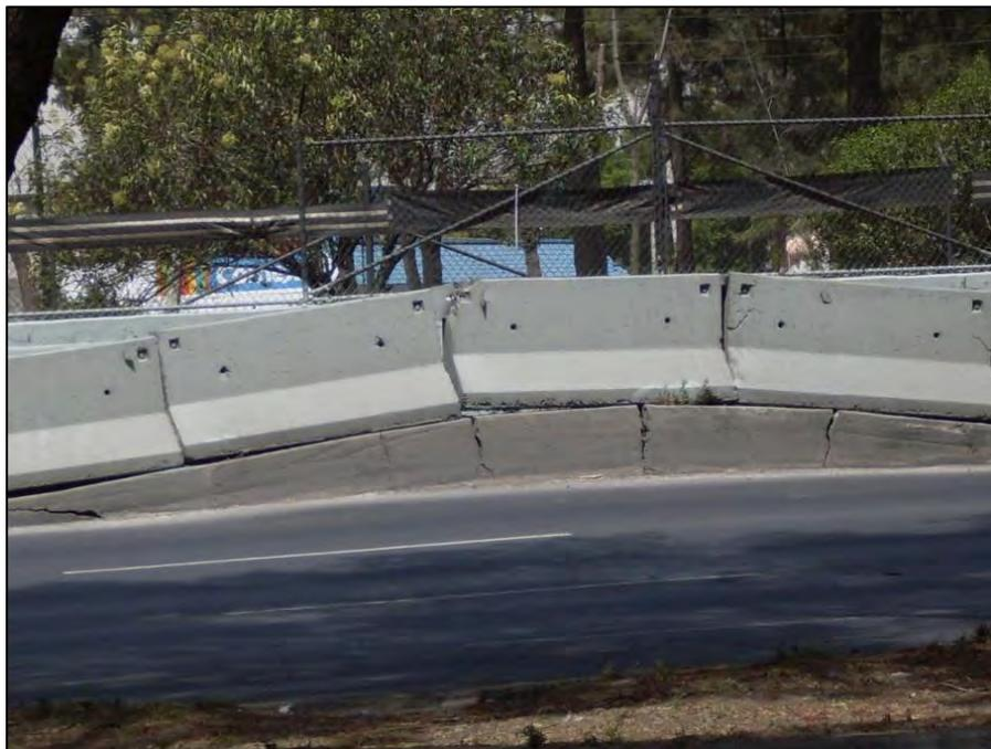
**Figura 4.23.-** Un daño importante se localiza a lo largo de la Calzada Ignacio Zaragoza, causando deformaciones en las dovelas de los carriles de la línea A del Metro.
