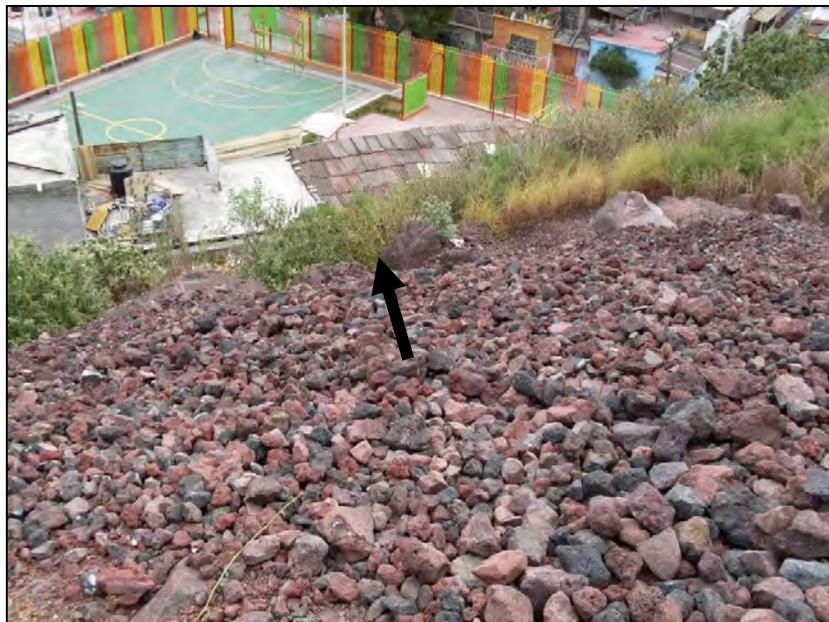
**Figura 4.14.-** Material suelto sobre la pendiente. Abajo existen viviendas con techo de lámina y una zona de juegos.
