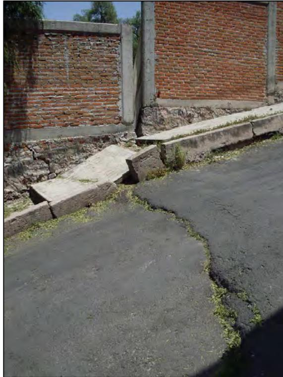
**Figura 4.22.-** Aspecto de los daños causados en bardas, banquetas y en la carpeta asfáltica.
