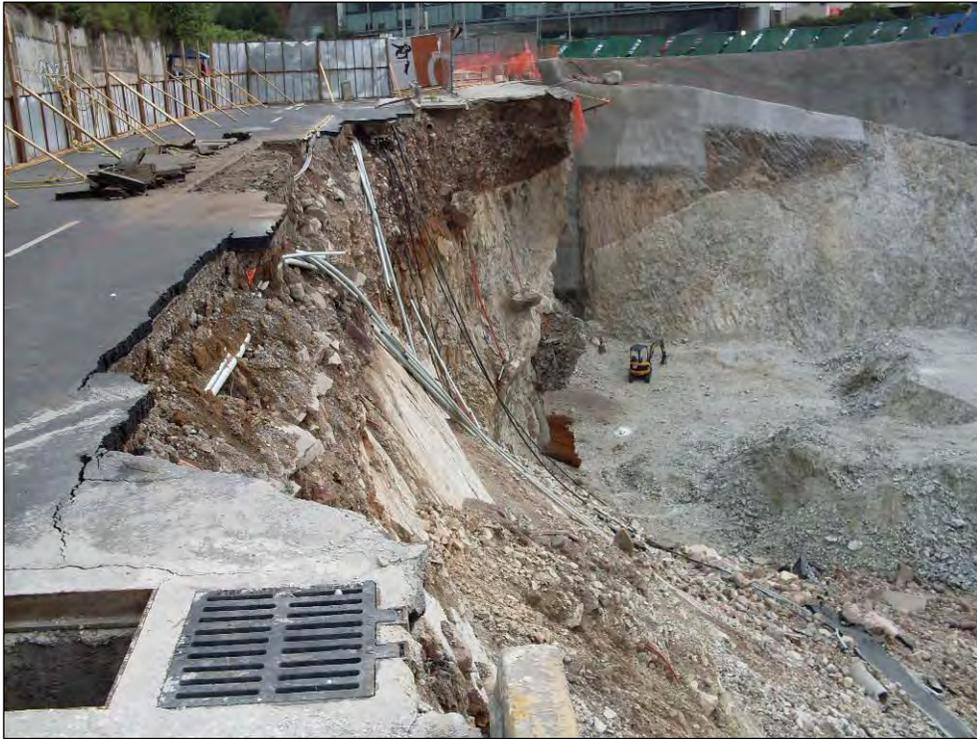
*Falla al interior de una excavación en la zona de Santa Fe, Cuajimalpa.*
