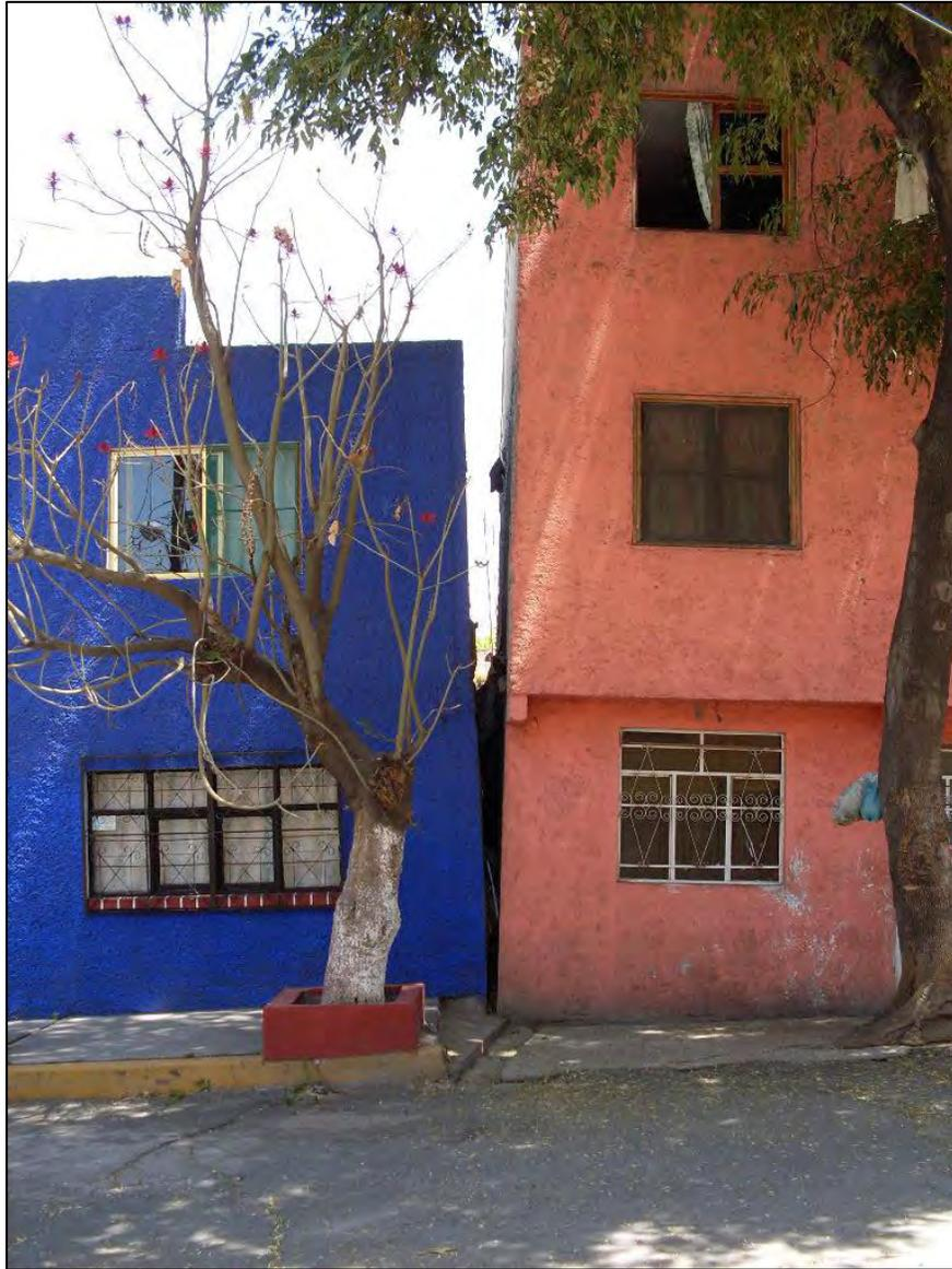
**Figura 4.21.-** En la traza de las grietas se crean desniveles, causando inclinación de las viviendas así como daños en su estructura.
