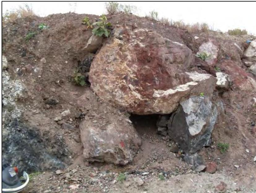
**Figura 4.12.-** Bloques sueltos simplemente apoyados, en un camino de terracería.
