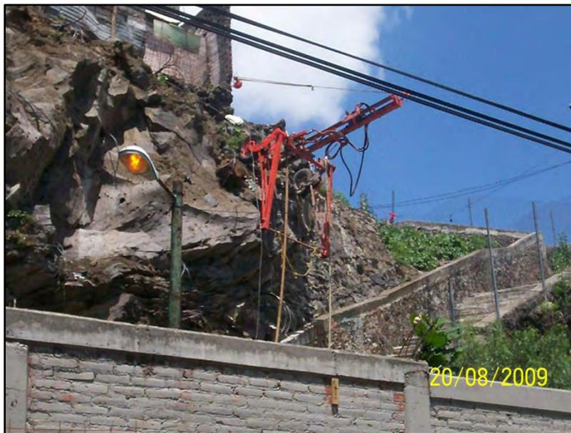
**Figura 5.23.-** Barrenación en grandes bloques de roca para la colocación de anclajes.
