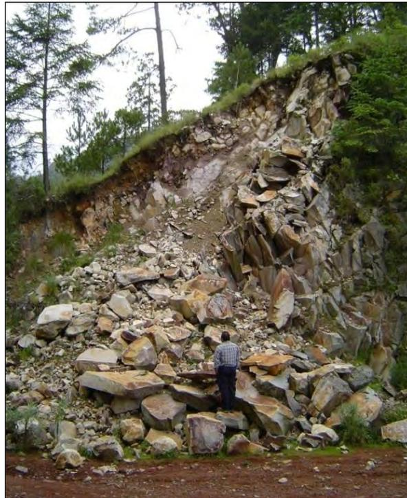
**Figura 6.7.-** Deslizamiento combinado con volteo en macizos rocosos fracturados.
