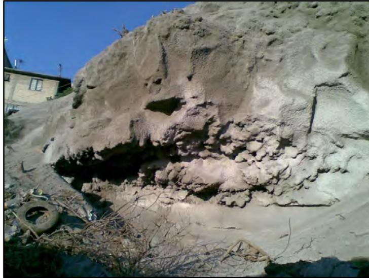
**Figura 5.14.-** Bloques tratados con concreto lanzado, pero con la condición de inestabilidad latente, dada por su pérdida de apoyo en la base del bloque.
