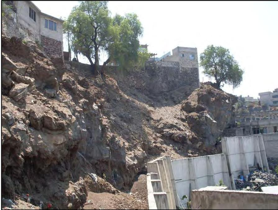
**Figura 5. 13.-** Aspecto del frente rocoso con señales de erosión en su base.
