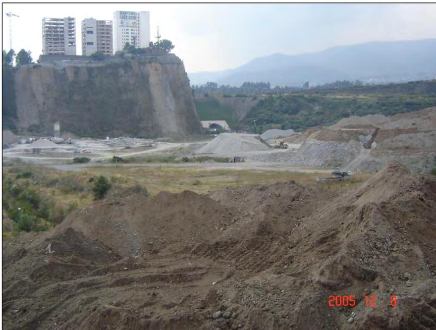
**Figura 6.51.-** Modificación del relieve para habilitar terrazas para la construcción, poniente del Distrito Federal.
