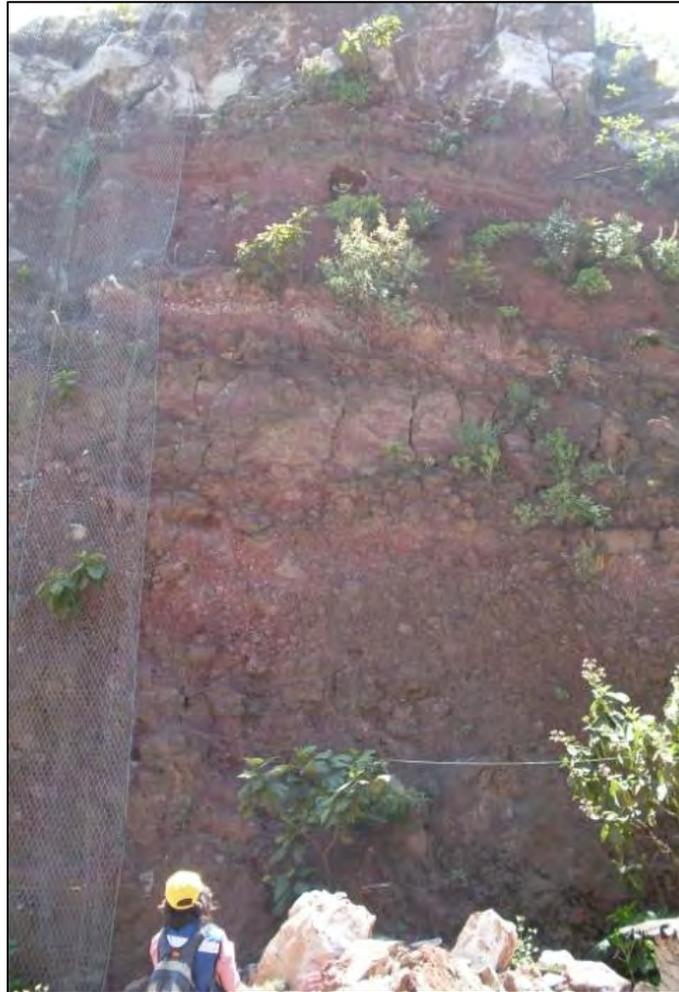
**Figura 4.10.-** Graneo en los materiales formados por escoria volcánica y caída de bloques.
