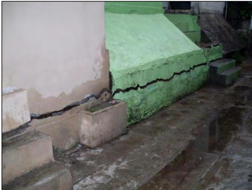
**Figura 4.20.-** Daños en construcciones sujetas a hundimientos diferenciales excesivos.
