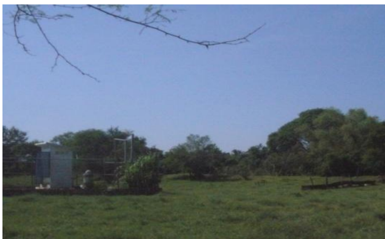
Foto 5.2. Fuente de abastecimiento de agua potable ubicada en la población de La Mira, Michoacán
