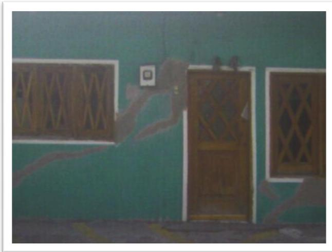
Figura 2 Vivienda en Santa Cruz Meyehualco con reparaciones en su pared debido al agrietamiento
