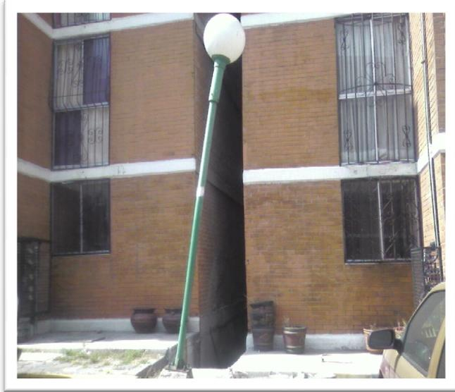
Figura 6 Los daños por el hundimiento del suelo en la Unidad habitacional La Concordia se reflejan en la separación de 50 cm que existe entre edificios.
