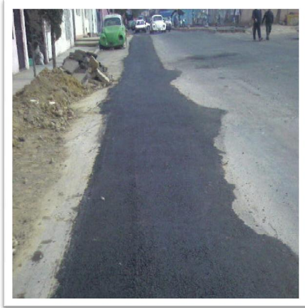
Figura 8 Grieta que se abrió en la Colonia Ejército de Oriente en febrero de 2008, actualmente está cubierta con bentonita.
