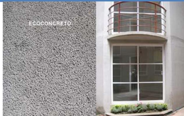
El ecoconcreto facilita la infiltración de agua de lluvia al subsuelo, necesaria para los mantos acuíferos.
