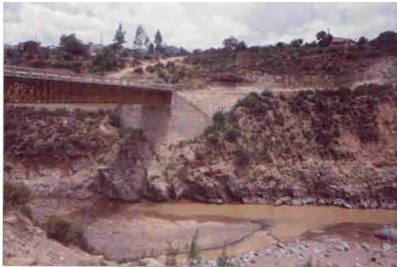
Foto 9: Puente que atraviesa el Apulco, para llegar a Yahuitlalpan.
