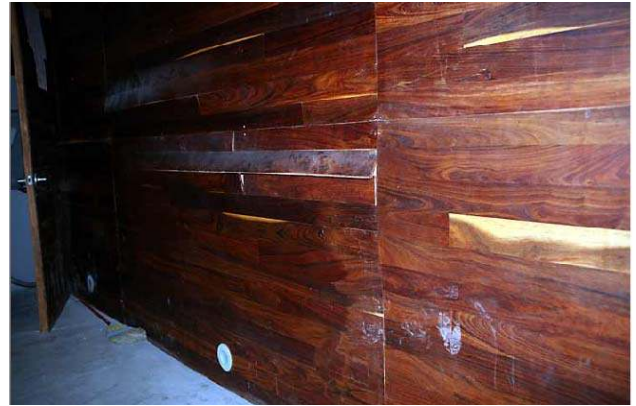
Imag. 14 Se reparan las filtraciones en el auditorio que lo hacían susceptible de inundaciones.
