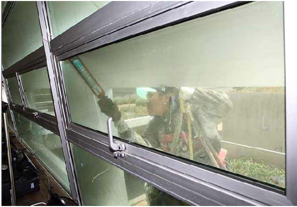
Imag. 13 Los trabajadores sellan con silicón la cancelaría de las fachadas para evitar filtraciones.
