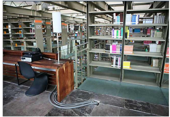
Imag. 8 Las instalaciones se observan sin instalar adecuadamente y los muebles de madera con raspaduras.
