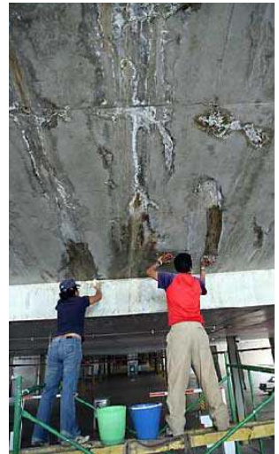
Imag 12 Limpieza del sarro dejado por las goteras con una solución de agua y ácido muriático.
