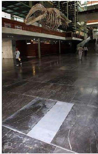
Imag. 10 Las planchas de mármol recién colocadas son lavadas con ácido para darles la tonalidad apropiada.
