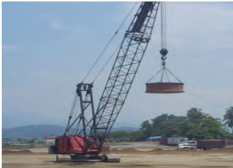
Figura 3.1 Grúa montada sobre oruga de 110 toneladas de capacidad de carga.
