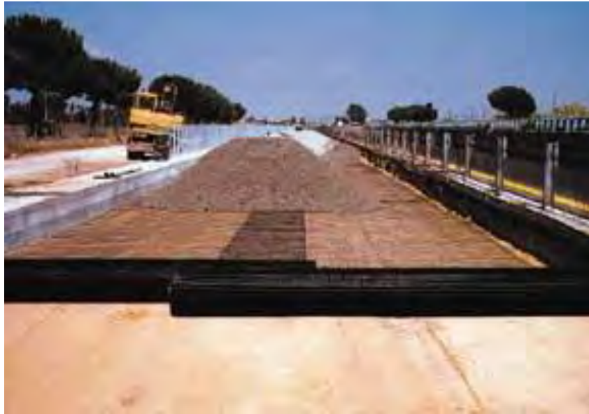
Figura 3.10 Estabilización con geotextiles.
