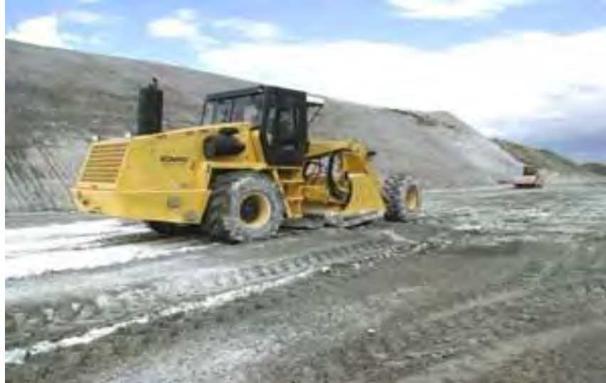
Figura 3.8 Estabilización con cal.
