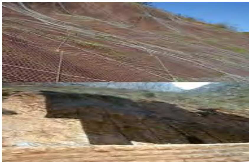
Figura 3.13 Estabilización de talud con geomallas.
