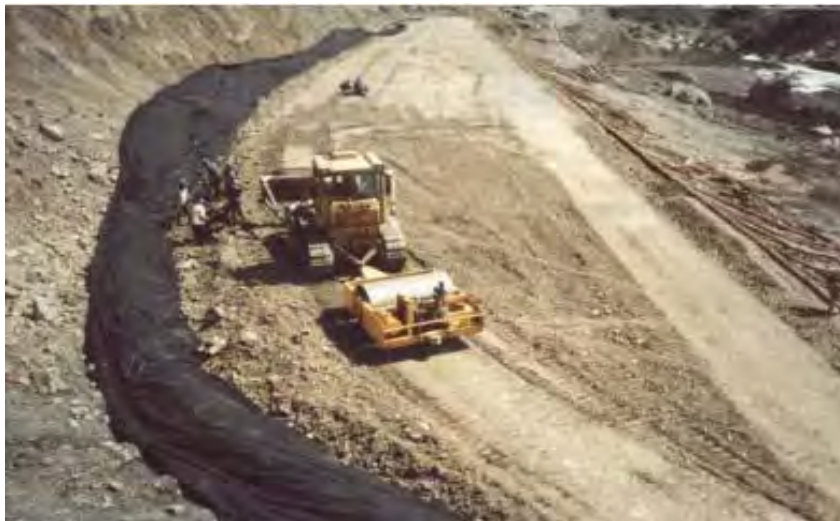
Figura 3.14 Compactación del suelo por encima de la geomalla.
