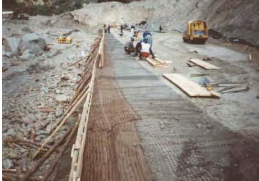
Figura 3.15 Colocación de la geomalla paralelo al talud.
