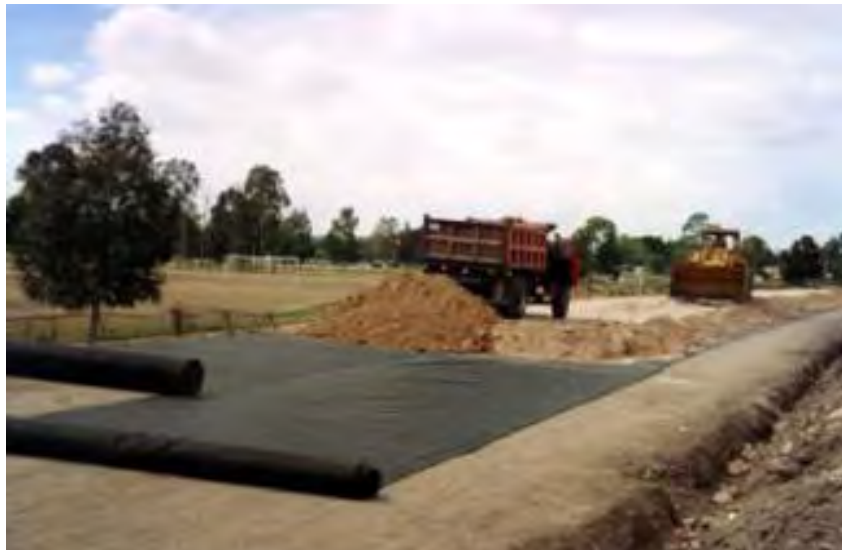
Figura 3.11 Estabilización de suelos con geotextiles.
