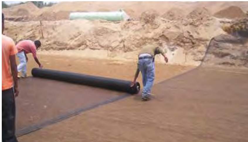
Figura 3.12 Estabilización de suelos con geomallas.
