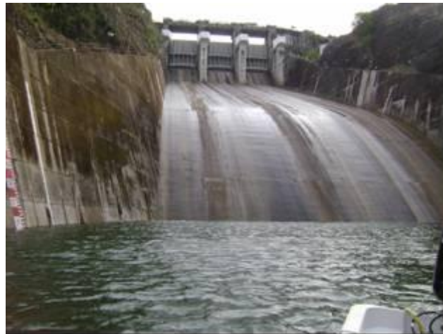
Figura 4-4 Vertedor Presa Malpaso
