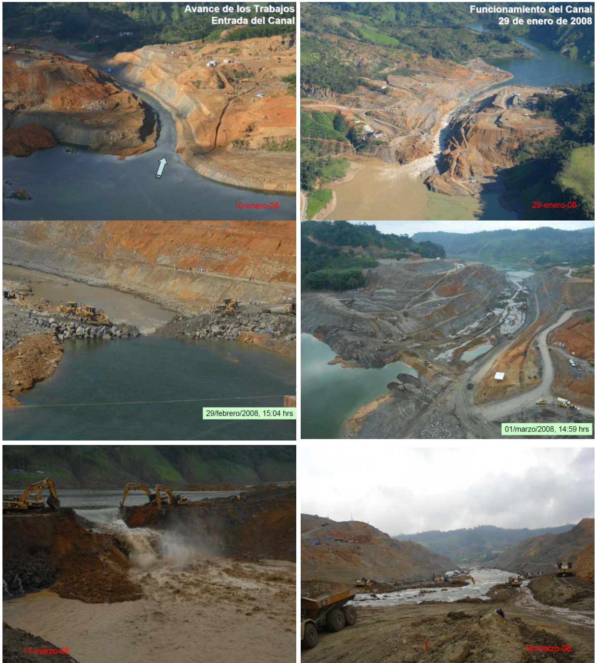
Figura 4-7 Segunda etapa de construcción del canal, del 18 de diciembre de 2007 al 18 de marzo de 2008, río Grijalva, Chiapas.
