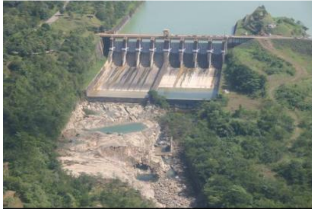
Figura 4-5 Vertedor Presa Peñitas
