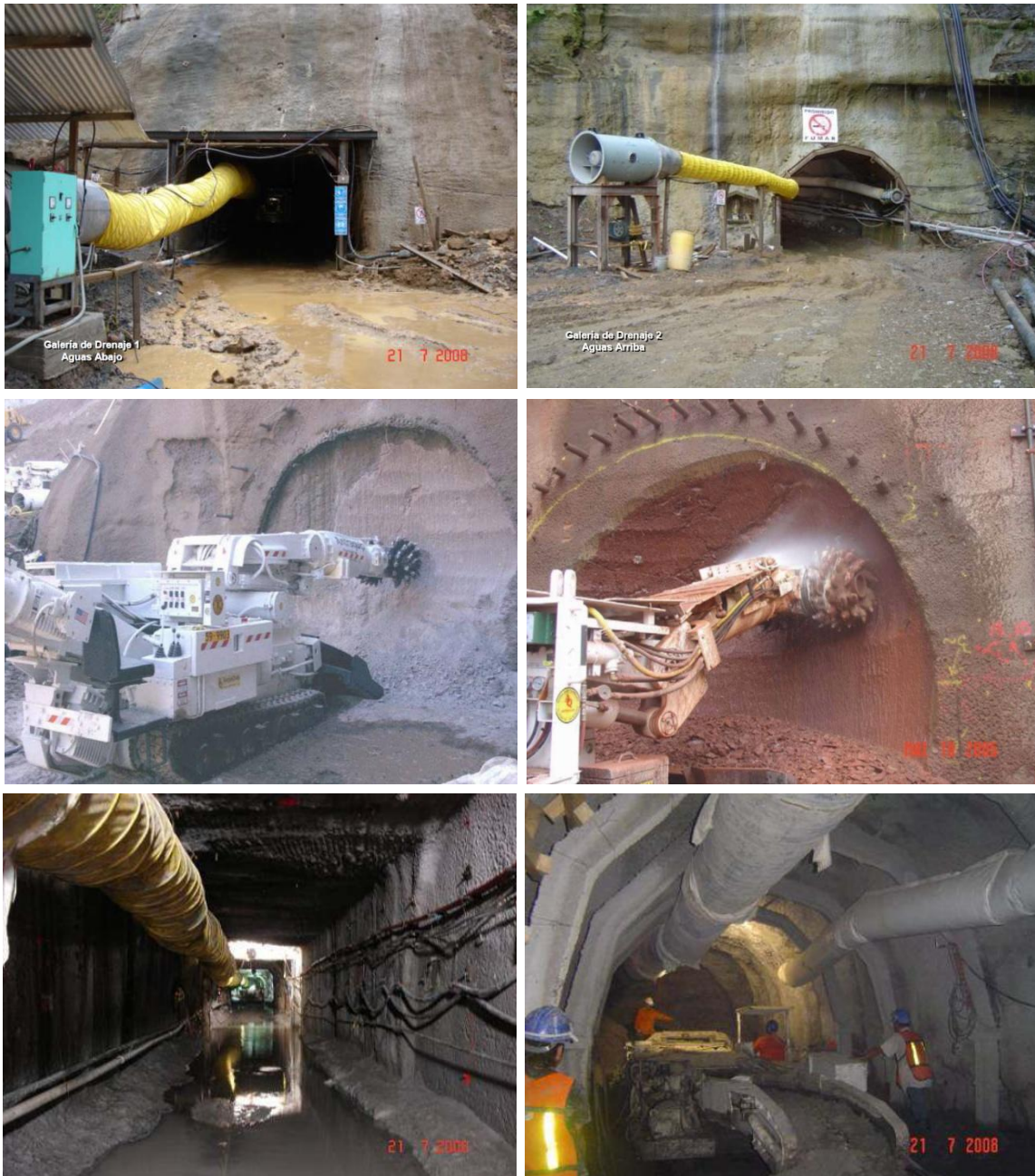
Figura 4-9 Tercera etapa, Construcción de la galería de drenaje, río Grijalva, Chiapas.
