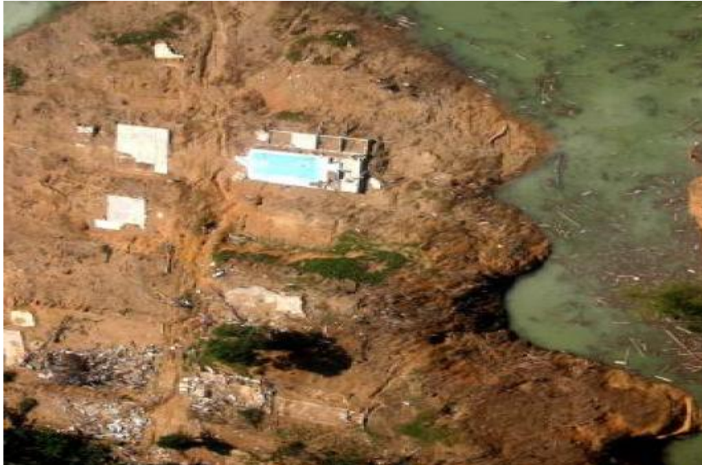
Figura 3-10 San Juan de Grijalva después del deslizamiento de tierra, río Grijalva, Chiapas.
