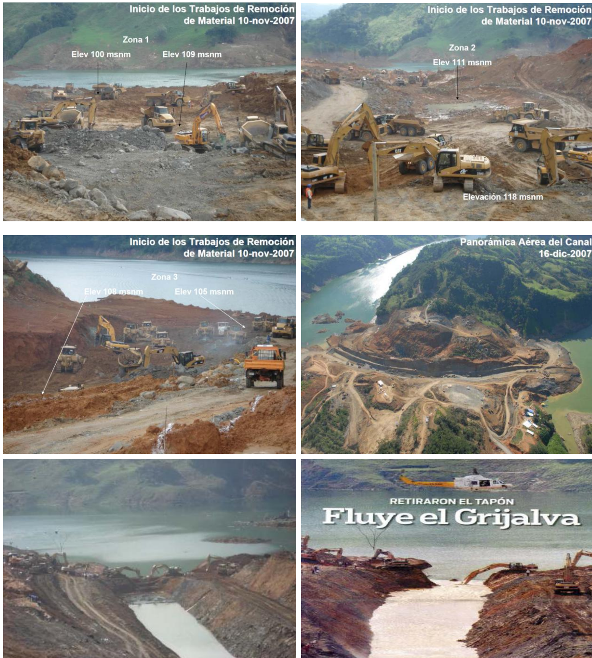
Figura 4-6 Primera etapa de construcción del canal, del 10 de noviembre al 18 de diciembre de 2007, río Grijalva, Chiapas.
