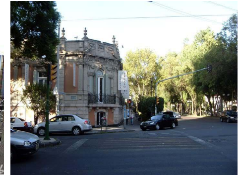
fig.07 casa Lamm, esq. Álvaro Obregón-Orizaba
