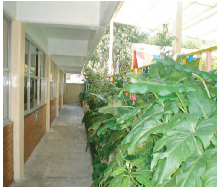
Pasillo: aquí se muestra el poco espacio que hay entre salones y la jardinera por este motivo serán colocadas señales de mural.
