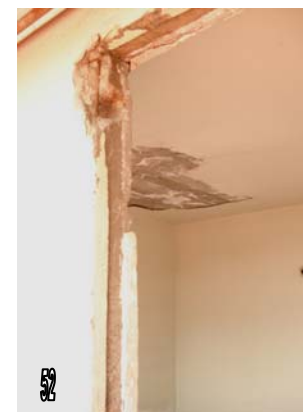
48 , 49 y 50. Detalle del estado de las vigas metálicas en el 5to. nivel debido a filtraciones de agua; 51. Grietas en algunos muros de block; 52. Detalle de las filtraciones de agua; 53. Cubierta de lámina curvada.
