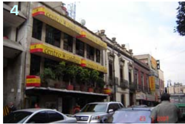
4 y 5. Edificios colindantes sobre la calle de República de Uruguay.
