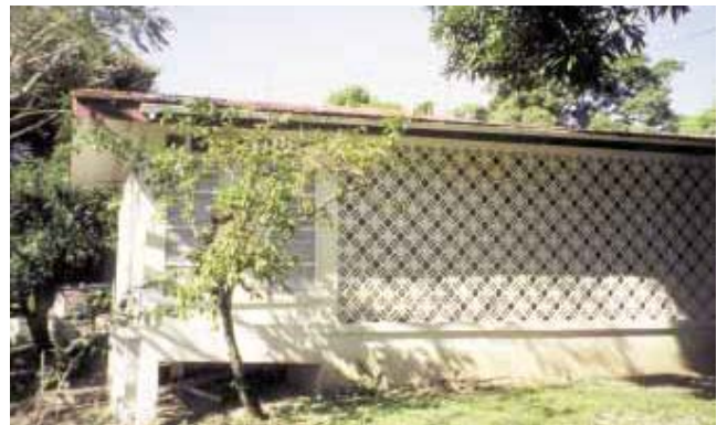
Figura 20. Pared del bloque de cemento decorativo, permite la ventilación y proporciona la cortina, transmitiendo solamente la luz. Imagen tomada de la red con fines didácticos.
