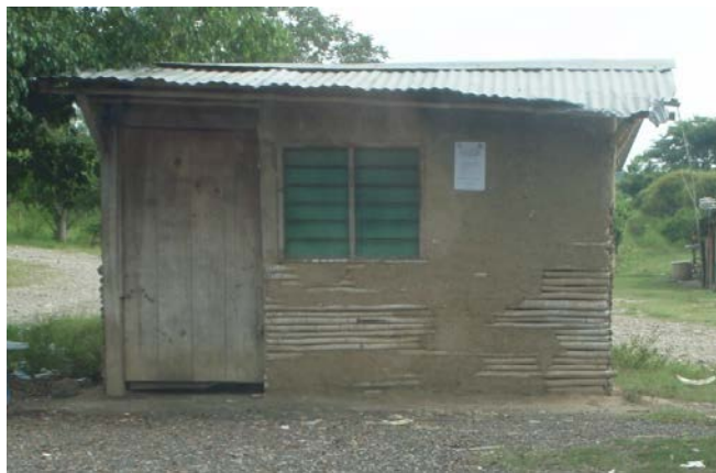
Figura 47: Vivienda. Casas viejas Veracruz. Municipio Tamtoyuca. Carrizos de los muros colocados de manera horizontal © Cuán, María. 2010
