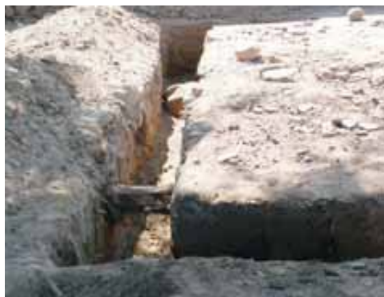
Figura 48: Cimentación de vivienda de embarre. Imagen tomada con fines didácticos.
