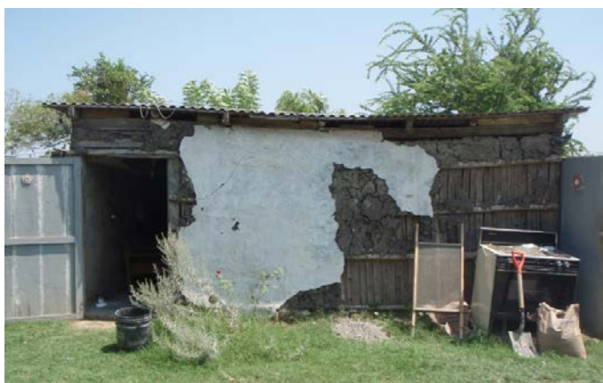
Figura 46: Vivienda. Municipio Tamiahua. Carrizos de los muros colocados de manera vertical © Cuán, María. 2009
