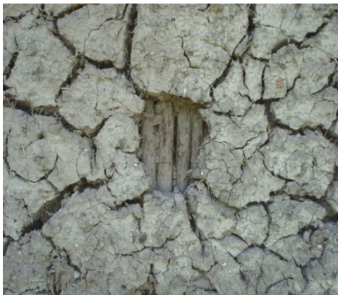
Figura 19. Muro de embarre, Tamiahua Ver. © Cuán, María. 2009.
