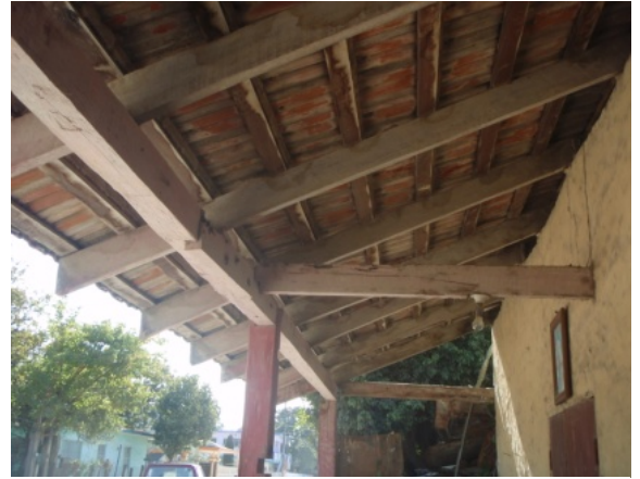
Figura 69. Cubierta de la vivienda vernácula. ©Cuán, María. 2010.
