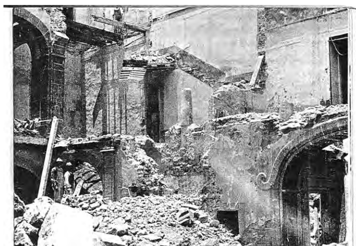
Figura 14. Aspecto de la demolición del Hospital Real de Naturales. (Tomado de Venegas, 1973)
