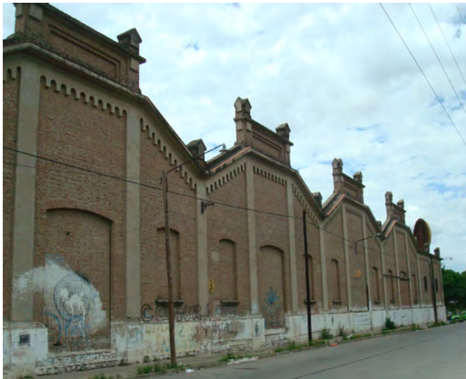
Figura 31. Cervecería Córdoba, maneja el mismo lenguaje que caracteriza a la arquitectura industrial en diversas latitudes, al menos de América Latina. Fotografía tomada por la autora, Córdoba Argentina, 2009.
