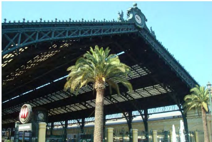
Figura 23. Estación de Santiago, donde se puede ver la misma tipología arquitectónica en el uso de techos a dos aguas y cerramientos de mampostería. Fotografía tomada por la autora, Santiago de Chile, 2009.
