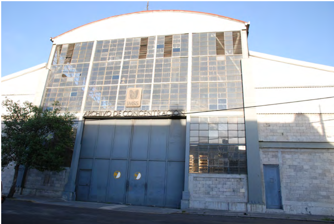
Figura 55. El archivo de concentración de expedientes del IMSS, con una parte de la cancelería original y otra sustituida por block de concreto. Fotografía tomada por Alonso David, México, 2010
