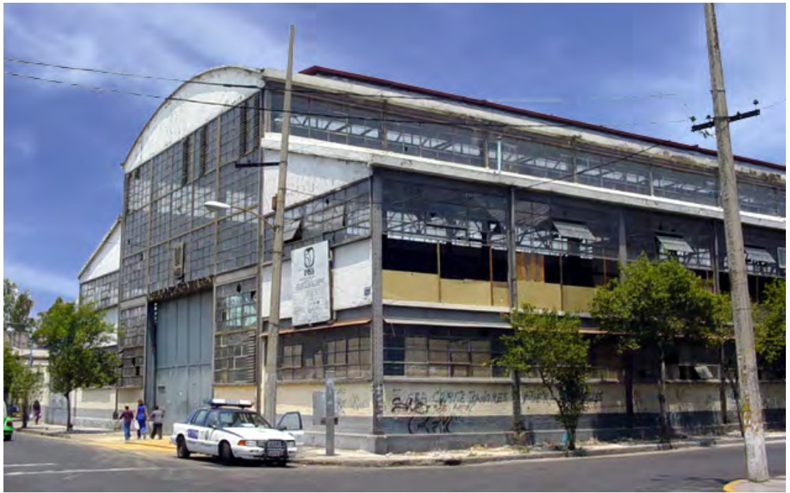
Figura 27. Actual archivo de concentración del IMSS, donde se puede observar los muros de manguetería y vidrio, con rodapie de ladrillo aplanado, y cubierta curva. Destaca la gran puerta metálica y las divisiones de nivel por medio de vigas. Fotografía tomada por la autora, México DF, 2010.
