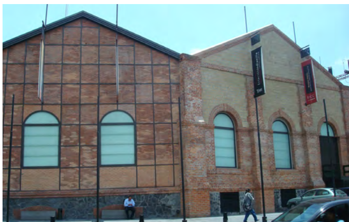
Figura 30. Antigua estación indianilla en la colonia doctores, lugar de mantenimiento de los tranvías de la ciudad de México para principios de siglo, donde se puede observar el uso de enmarcamientos metálicos y cerramientos de tabique. Fotografía tomada por la autora, México, 2010.
