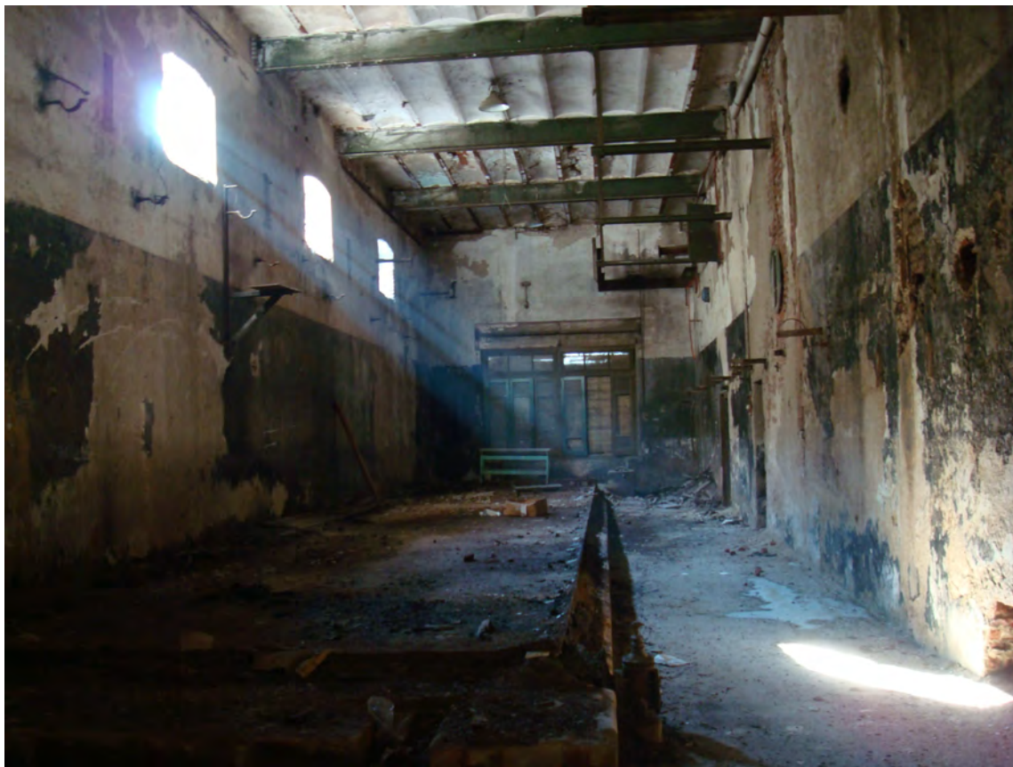
Figura 68. Interior de la Cervecería Córdoba. Ahora en abandono, pero con una belleza de sensaciones, las texturas de las paredes, la luz que atraviesa el polvo. Se ve también los materiales de la cubierta, con bovedas y tirantes metálicos.
