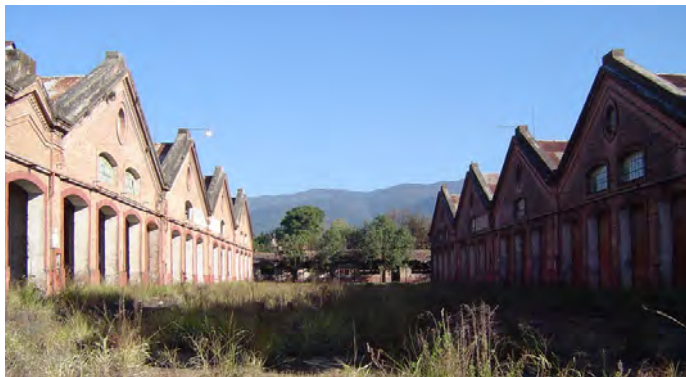
Figura 28. talleres del Ferrocarril Central, la arquitectura industrial maneja una tipología que la identifica en diversas latitudes. Fotografía tomada por la autora, Tucumán, Argentina, 2009.
