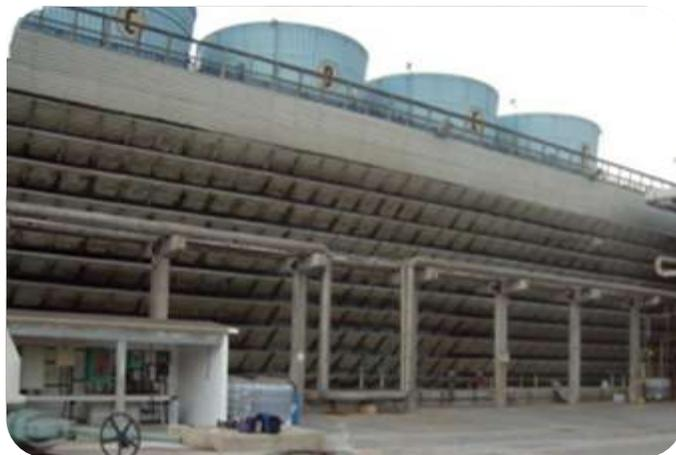
**Figura. 8** Torre de enfriamiento multicelda de tiro inducido y flujo cruzado.
