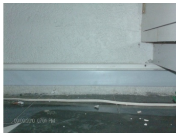
Figura 64. Pegado de canaleta en almacén.
