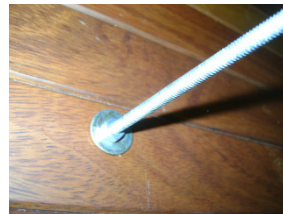
Figura 33. Colocación del rack
