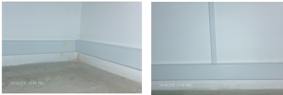
Figura 59. Canaleta fijada en el centro de servicio.
