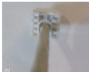
Figura 92. Jack de datos con tapa protectora
