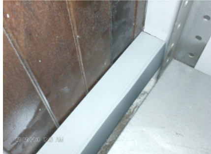
Figura 55. Canaleta puesta en madera en el centro de servicio.
