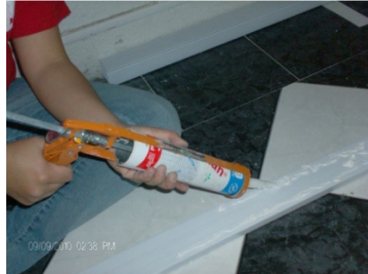
Figura 38. Distribución de pegamento en la canaleta.
