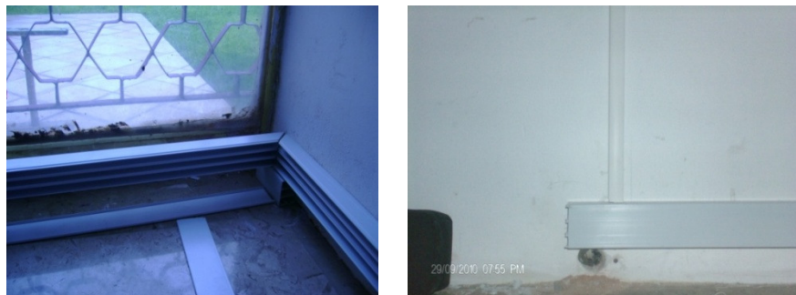
Figura 61. Canaleta pegada en el centro de servicio.
