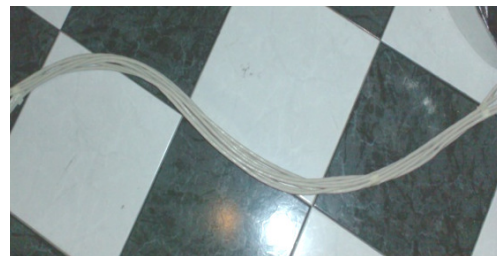
Figura 87. Cable UTP unido mediante cinta adhesiva.
