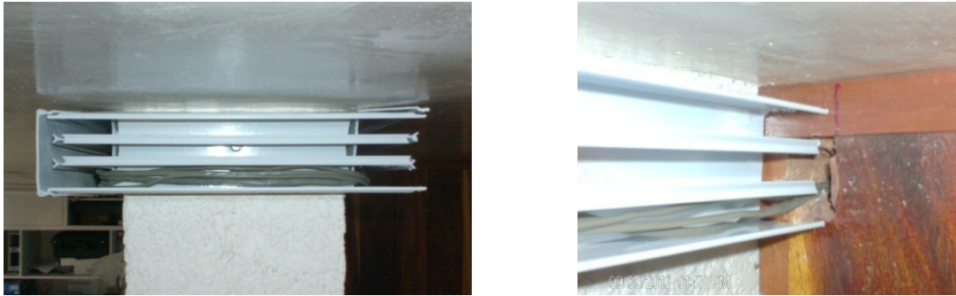
Figura 75. Cableado en el área de almacén.
