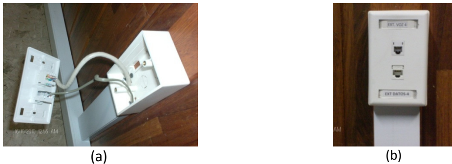
Figura 93. (a) Jack de voz y datos en las tapas plásticas, (b) Fijación de las placas plásticas.
