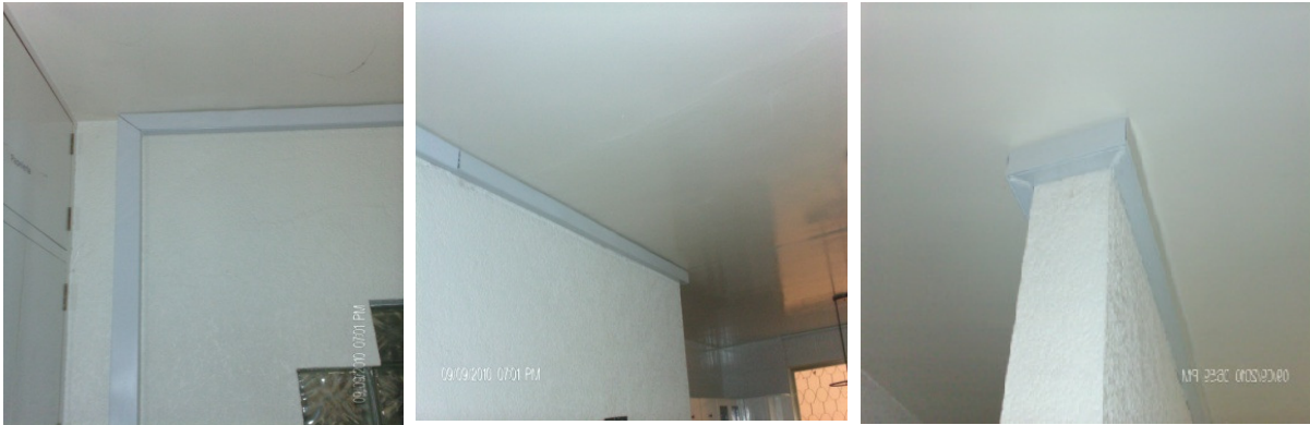
Figura 67. Canaleta fijada a concreto en almacén.
