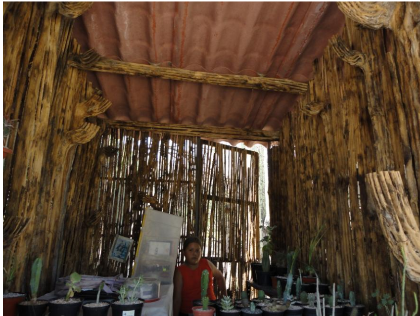
Fotografía 15. Construcción realizada con culotes de N. tetetzo .
