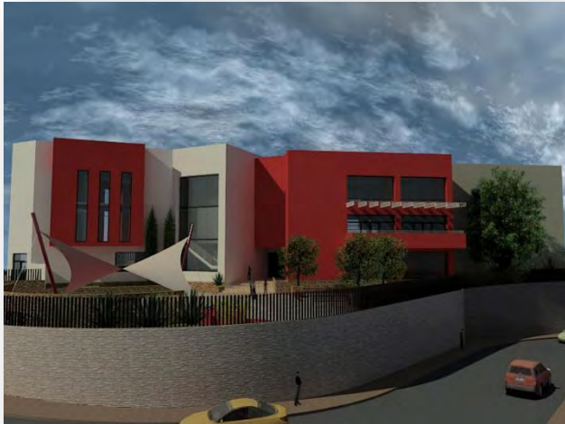
ILUSTRACIÓN 8 VISTA FACHADA SUR
