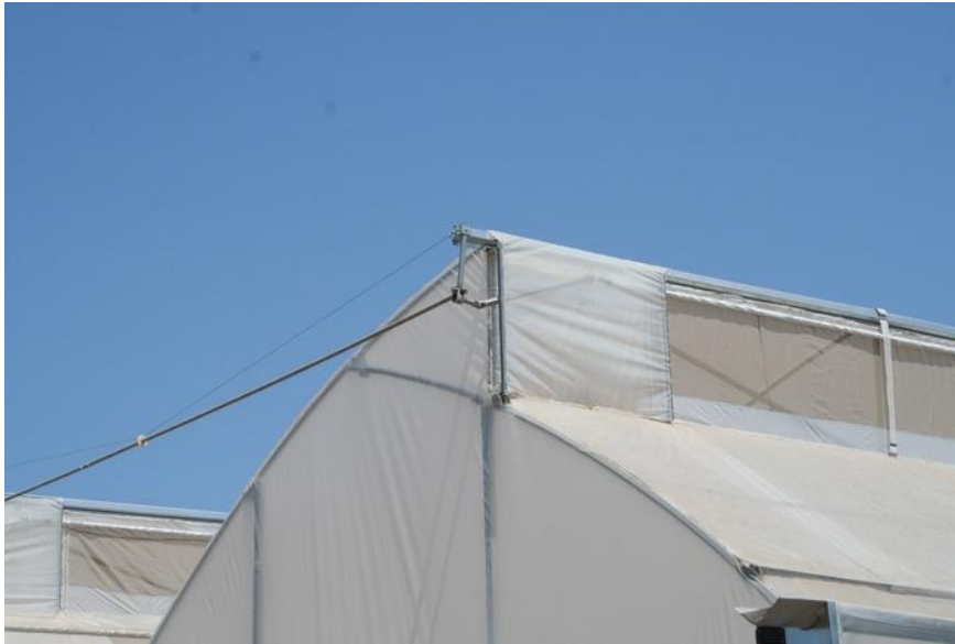
Fotografía 3 Invernadero tipo túnel con ventana cenital
