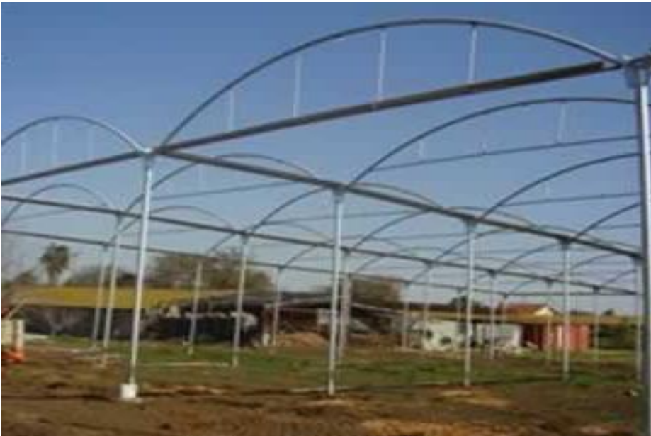
Fotografía 5 estructura del invernadero
