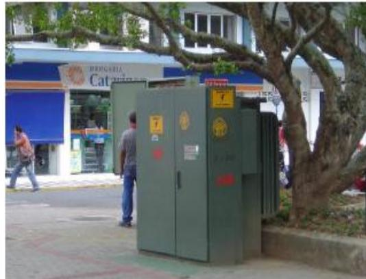
Además su instalación no es complicada, ya que puede reducirse a su posicionamiento donde haya una previa excavación, conectando los cables de acometida que entran a los centros de transformación precisamente por estas perforaciones en la base.
