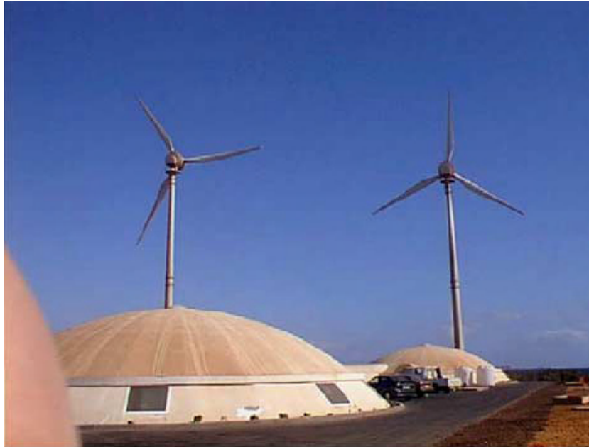
Figura 5.4. Parque eólico y los domos de desalinización en la isla Gran Canaria (Tzen y Morris, 2003)
