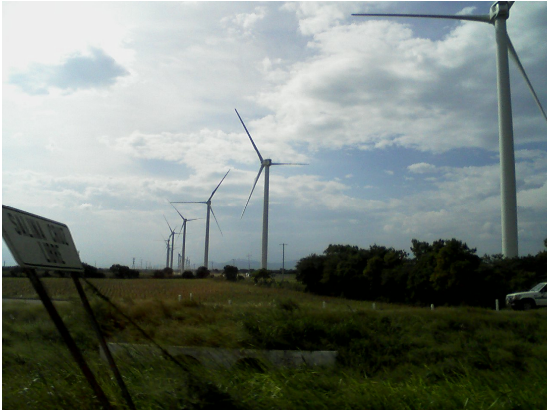
Figura 2.11. Foto de un parque eólico en La Ventosa, Oaxaca (Fotografía Arturo Romero-Rodríguez)
