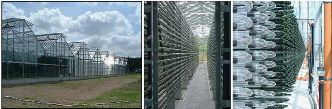
Figura 3.13 Fotobiorreactor más grande del mundo en Klötze, cerca de Wolfsburg, Alemania (Prof. Bioproducte Steinberg; www.algomed.de ). El volumen de trabajo (700 m 3 ) se distribuye en 500 km de tubos y produce hasta 100 T de biomasa de algas por año (Schenk et al., 2008)
