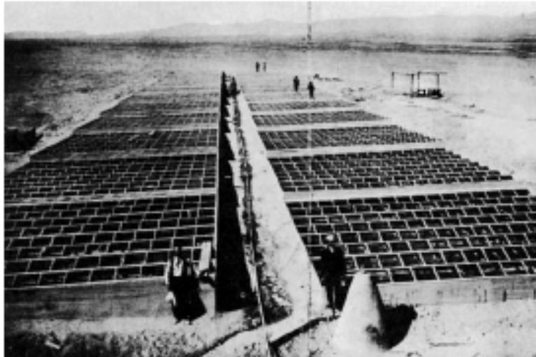
Figura 1.11. La primera planta destiladora del mundo en Las Salinas, Chile (Delyannis, 2003)
