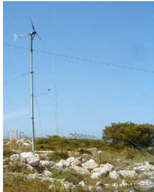
Figura 5.6. Arreglo de 4kWp, 900 W W/T en Lavrio, Grecia. (Tzen y Morris, 2003)
