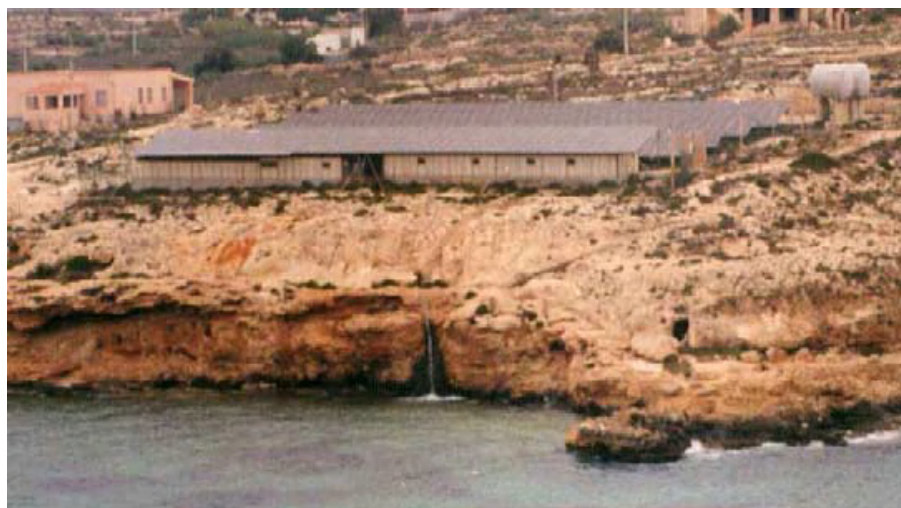
Figura 5.1. Sistema solar fotovoltaico de la planta fotovoltaico-ósmosis inversa en Lampedusa, Italia (Tzen y Morris, 2003)
