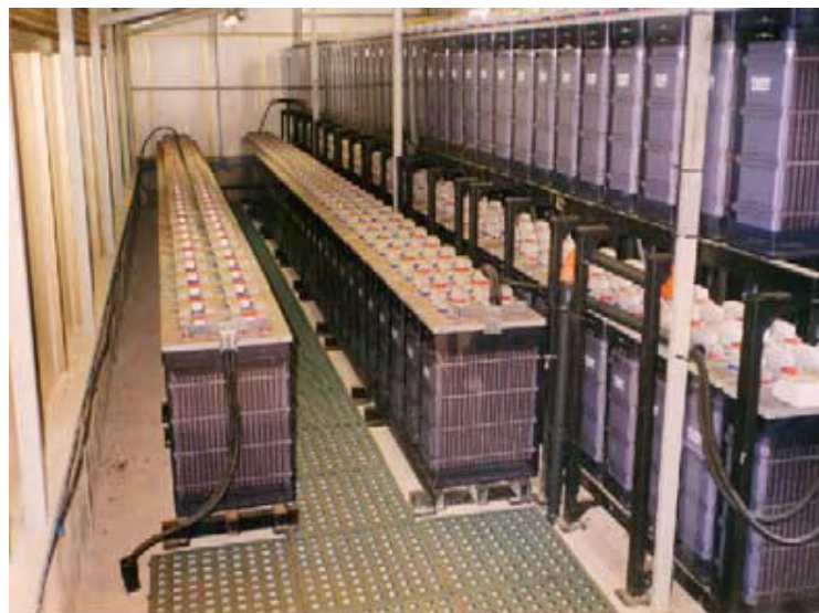
Figura 5.3. Sistema de banco de baterías de la planta en Lampedusa, Italia (Tzen y Morris, 2003)
