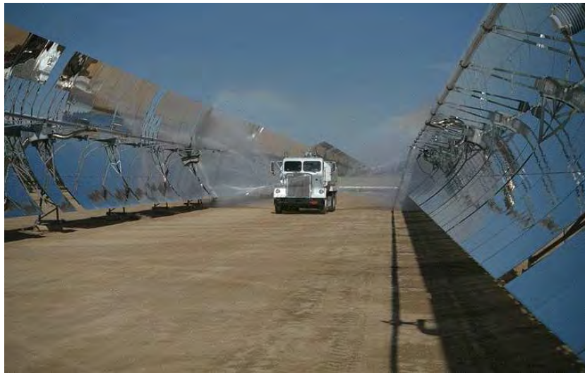
Figura 1.1: Proceso de lavado actual de los heliostatos en una planta solar
