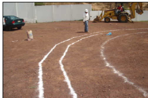
Figura 4.3.- Trazo de brocal sobre terreno.
