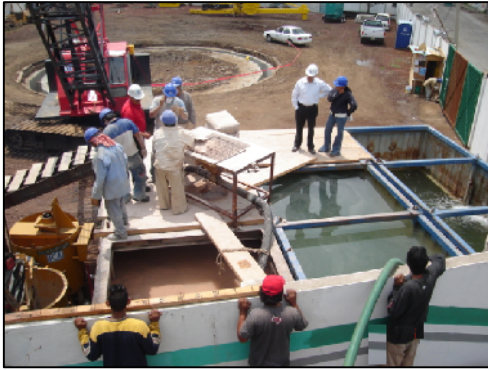
Figura 4.11 Preparación de lodo fraguante.
