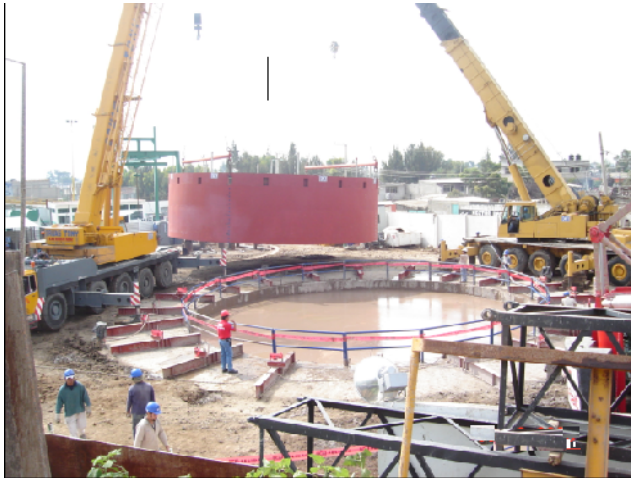
Figura 4.25 Maniobra realizada para la colocación de tanque metálico con ayuda de grúas
