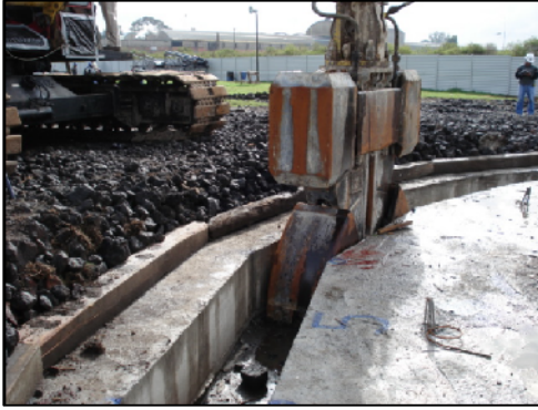
Figura 4.9 Excavación en el tablero.
