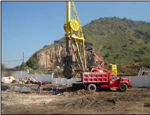
Figura 4.9 Excavación en el tablero.
