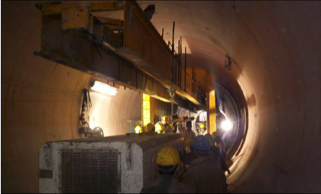
Figura A4.2. Cimbra telescópica colocada
