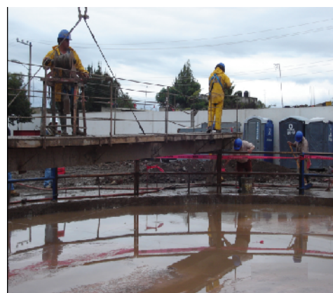
Figura 4.24 Plataforma para revisión de profundidad
