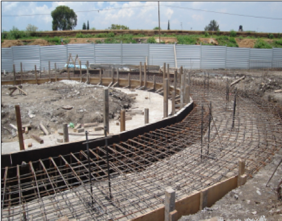
Figura 4.17 Armado del brocal definitivo
