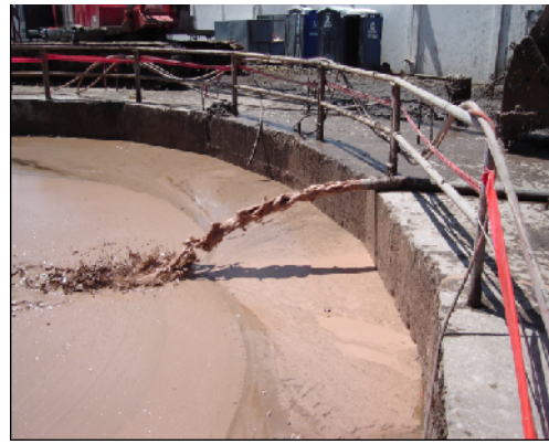
Figura 4.22 Nivel de lodo bentonítico a 50 cm como mínimo.
