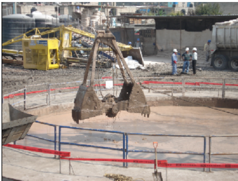
Figura 4.19 Extracción de material con almeja
