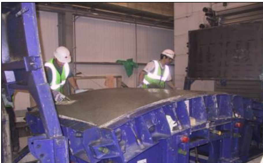
Figura A3.2. Colocación de acero en moldes
