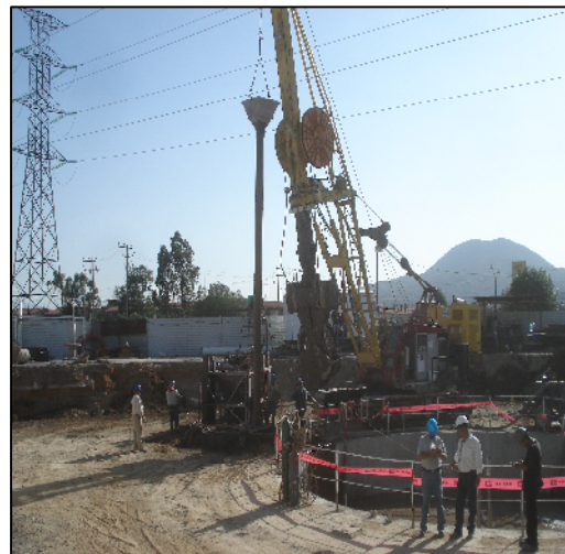
Figura 4.16 Colocación de mortero con tubería tremie
