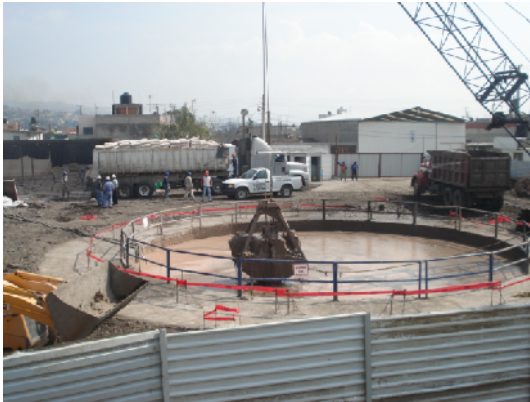
Figura 4.21 Extracción con almeja
