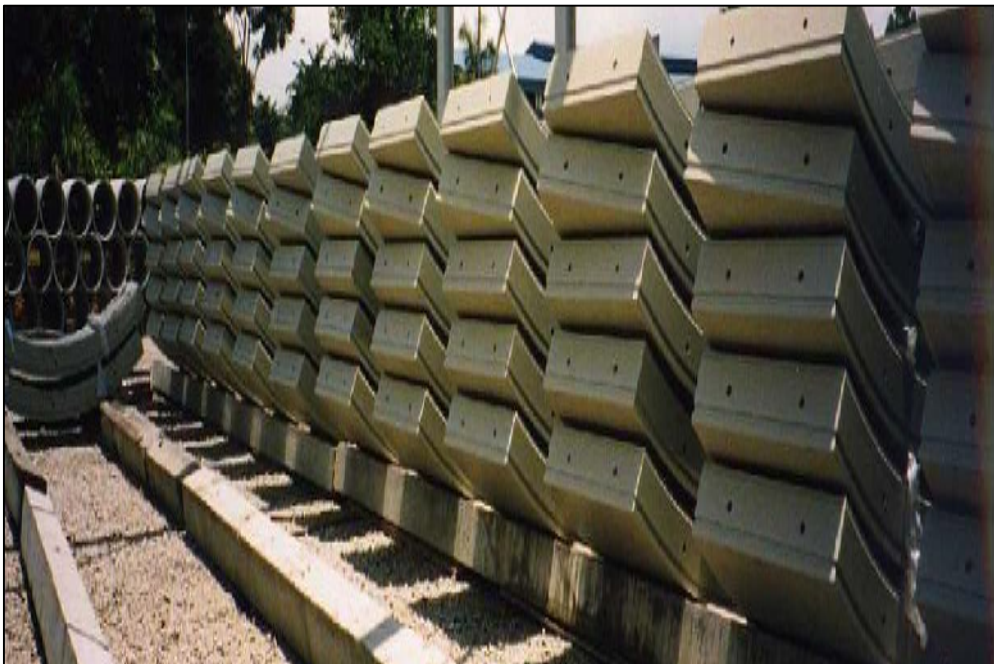
Figura A3.4. Almacenamiento de dovelas
