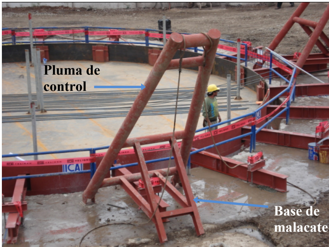
Figura 4.28 Plumitas de control perimetrales
