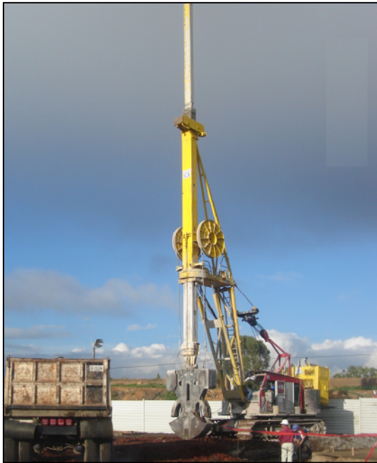
Figura 3.3.- Equipo guiado y centralina
