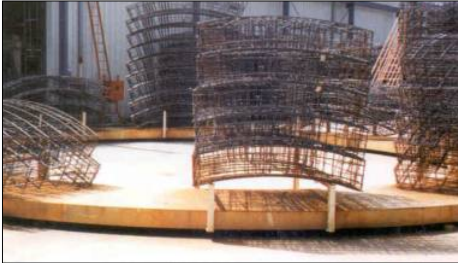
Figura A3.1. Habilitado y armado de acero de refuerzo
