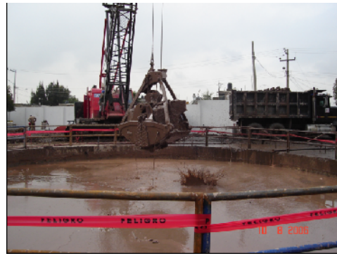
Figura 4.20 Extracción de material con almeja
