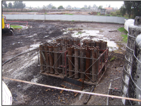
Figura 3.8.- Tubería Tremie
