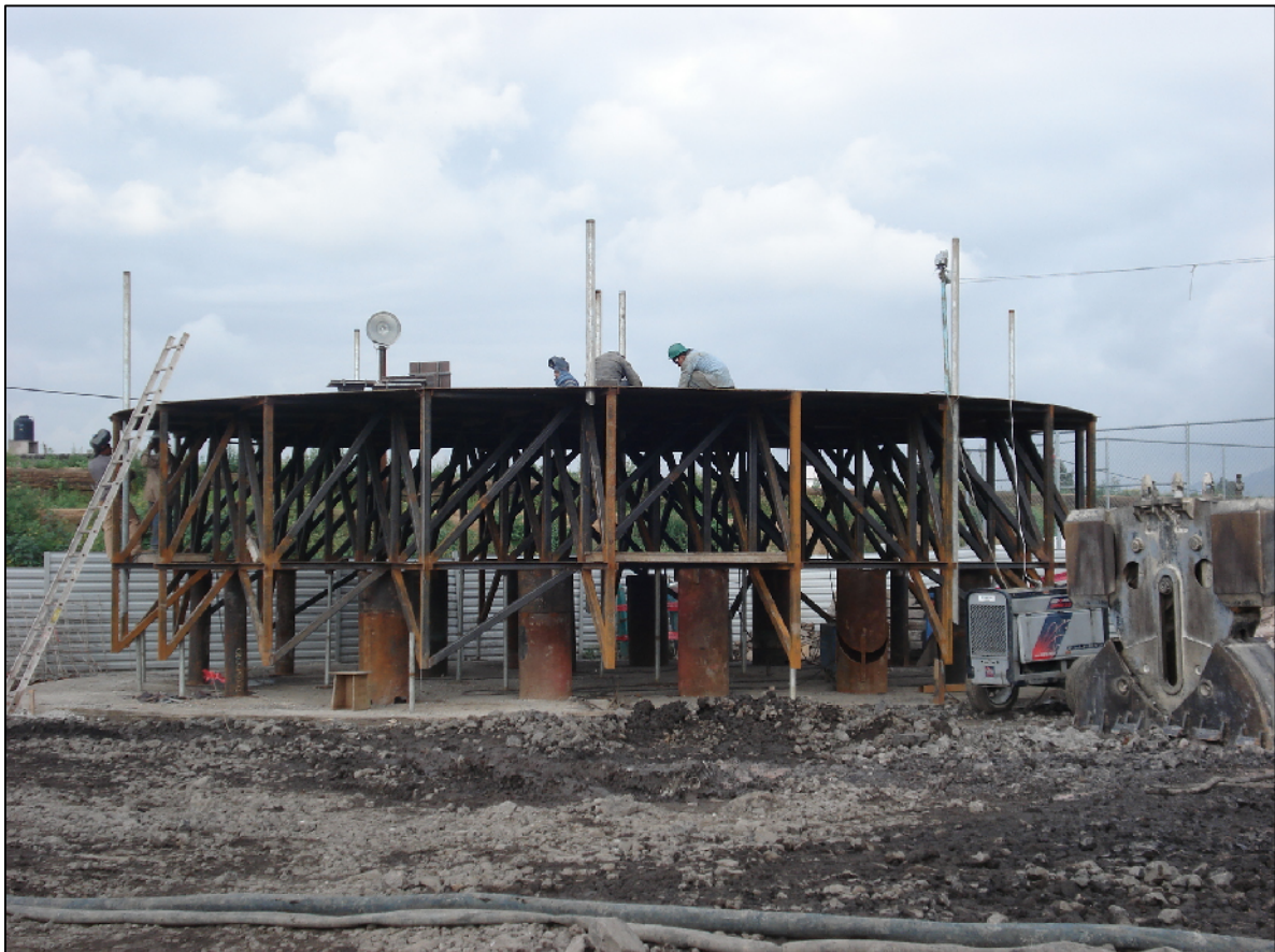
Figura A1.1 Armadura del tanque metálico
