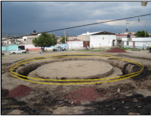
Figura 4.4.- Excavación y afinado de terreno para la colocación del brocales provisionales
