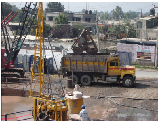
Figura 4.23 Descarga de almeja en camiones de volteo
