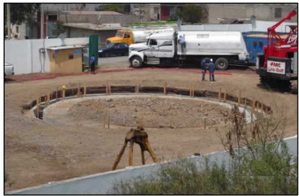
Figura 4.7 Terminado de brocales.
