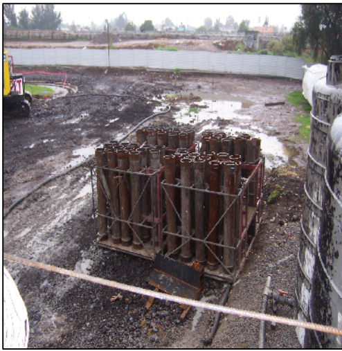
Figura 4.15 Tubería tremie
