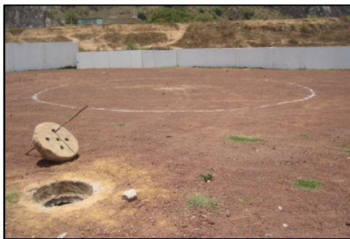
Figura 4.2.- Adecuación de terreno para área de trabajo.
