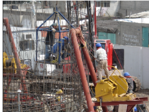
Figura 4.30 Armado de 1º muro de lumbrera.
