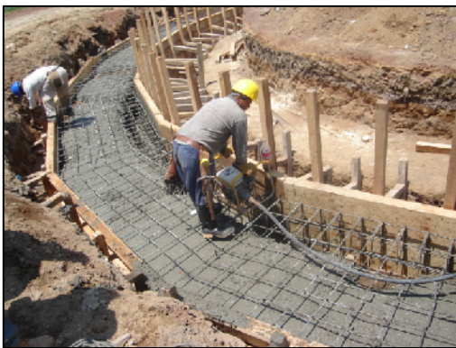
Figura 4.6. Colocación de concreto.
