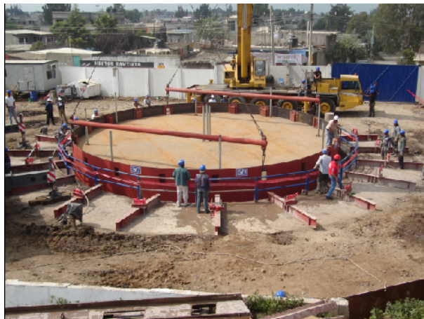
Figura 4.26 Inmersión de tanque en el interior de la lumbrera.
