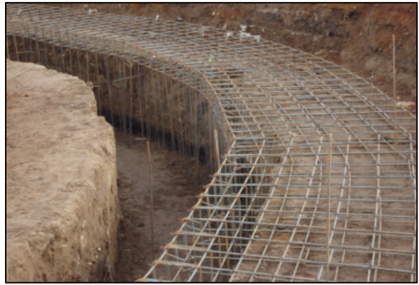
Figura 4.5. Armado de Brocal exterior provisional.
