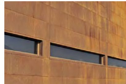
Material Propuesto para fachada, Multipanel F Cortén, Hunter Douglas. panel máximo de 6x6 mts.
