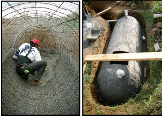
Figura 4.3 Instalación de un digestor tubular de ferrocemento (Rangel-Delgadillo, 2008)
