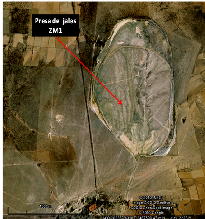
Figura 2.2.- Presa de jales localizada en la zona ZM1
