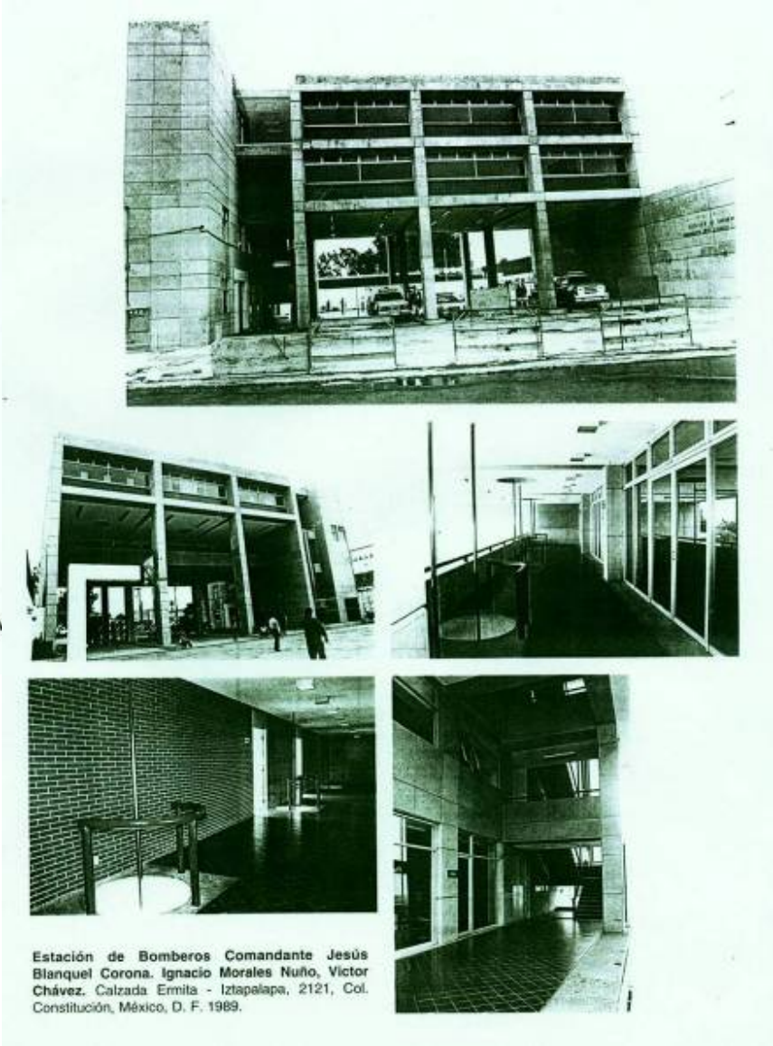
Estación de Bomberos Comandante Jesús Blanquel Corona. José Ignacio Nuño Morales, Víctor Cház Calzada Ermita-Iztapalapa 1221, Col. Constitución, México D. F. 1989.
