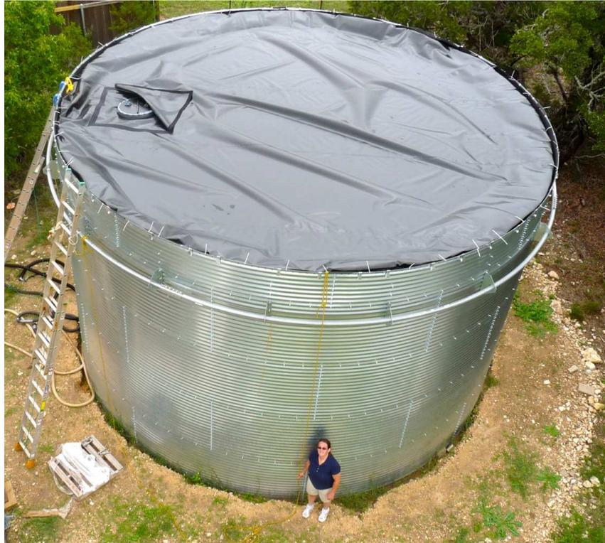
**Figura 3.10:** Prototipo de los tanques que formarán el arreglo HAWC, con 5 metros de alto y 7.3 metros de diámetro.
