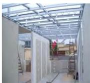
**DUROCK Y PREFABRICADOS: VENTAJAS:** El material prefabricado es usado en la actualidad casi en todos los centros comerciales y edificios en condominio, esto se debe a que la estructura se realiza con acero o concreto y después los muros interiores se hacen de material prefabricado, aligerando enormemente la carga del edificio.
