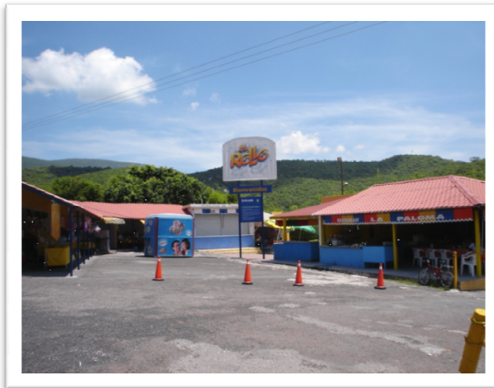
LOCALES COMERCIALES ACCESO Imagen 23
