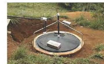
Fig. 100. Biogestor
