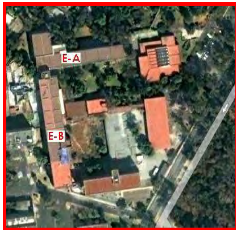
Fig. 5.3 Vista aérea del Posgrado de Ingeniería: Edificios A y B
