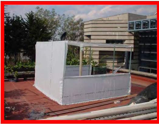
Fig. 4.12 Invernadero en construcción
