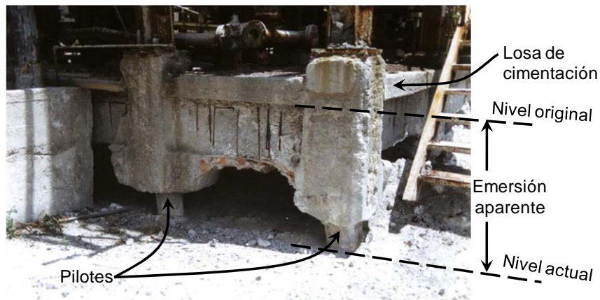
Figura 1.2.5 Emersión aparente de un grupo de pilotes de punta en el lago de Texcoco
