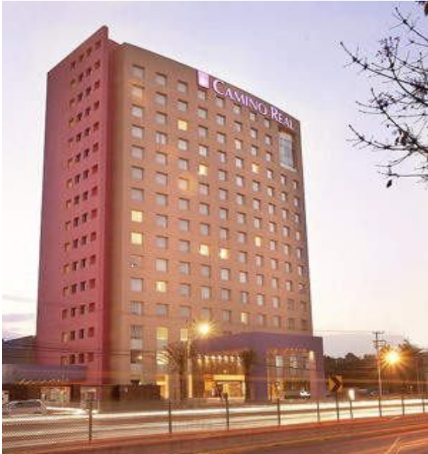
Fachada Camino Real
