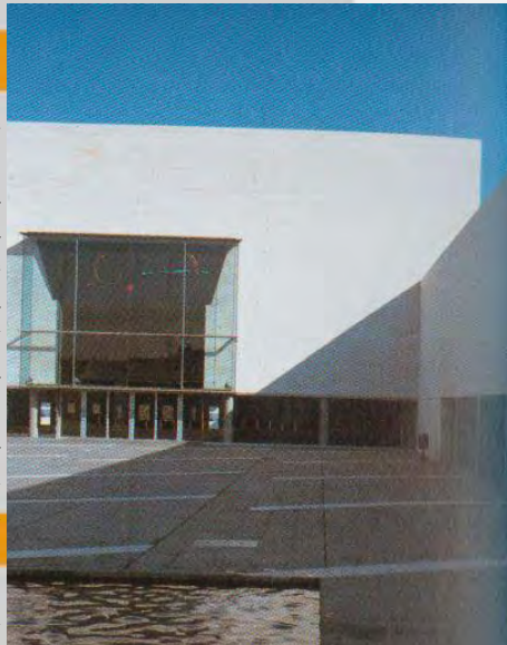
Frente del edificio
