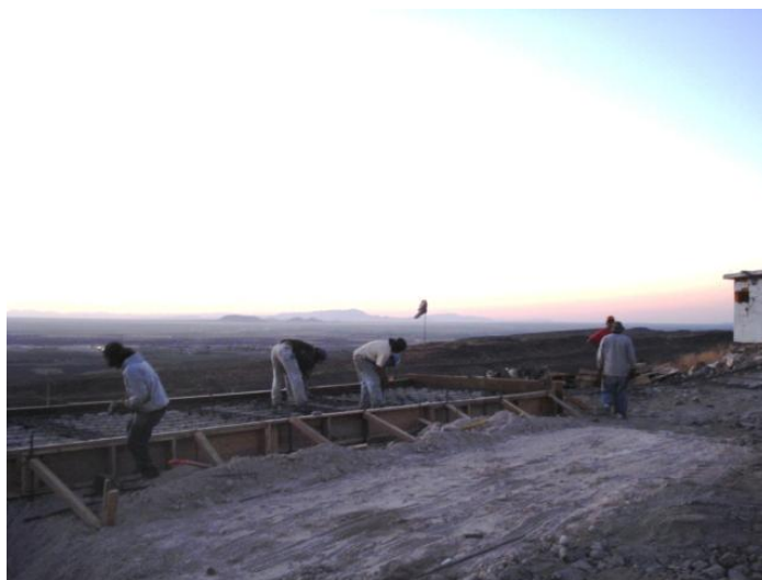
Figura 28. Preparación de base de caseta para su colado.
