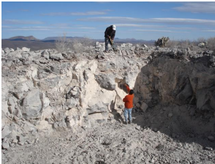
Figura 20. Terminación de la excavación.
