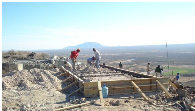
Figura 27. Cimbrado de base de caseta.
