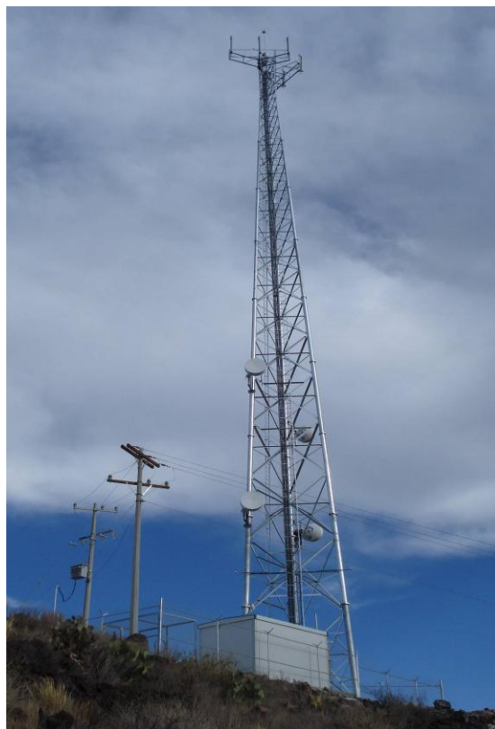
Figura 42. Radio base terminada.
