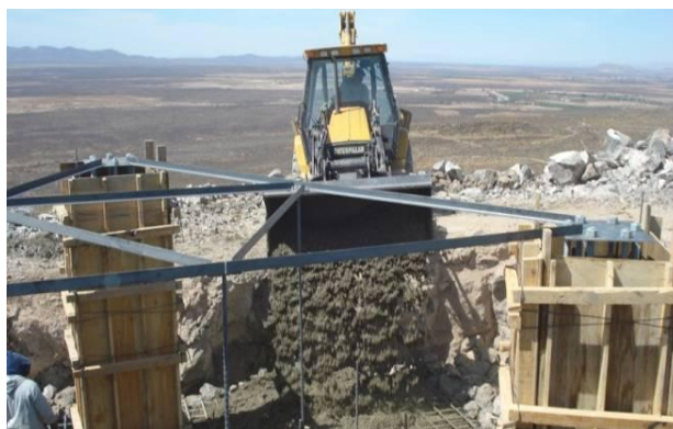
Figura 26. Apoyo con maquinaria para colado de zapata.
