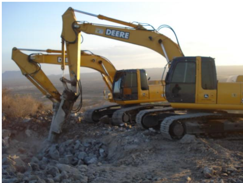
Figura 19. Inicio de la excavación.
