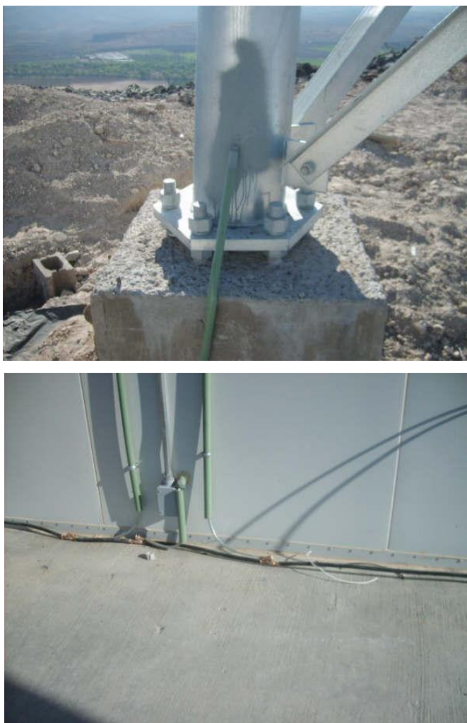
Figura 37. Sistema de Tierras terminado.
