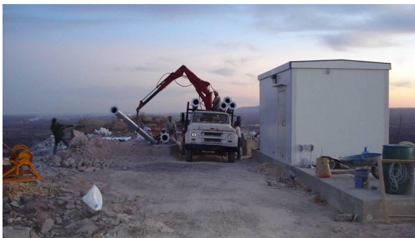
Figura 31. Descarga de Torre.
