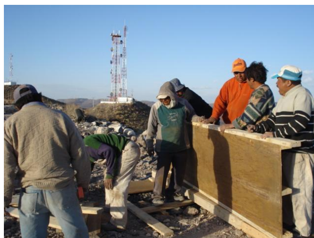
Figura 23. Habilitado de cimbra.
