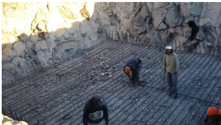
Figura 21 Colocación del acero para base de torre.
