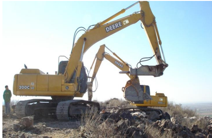
Figura 18. Acomodo de las máquinas para el inicio de la excavación.
