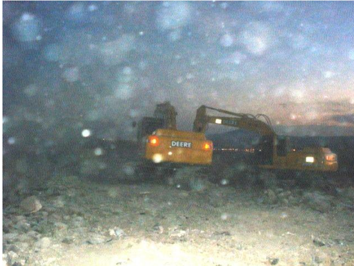
Figura 20. Trabajos de noche.
