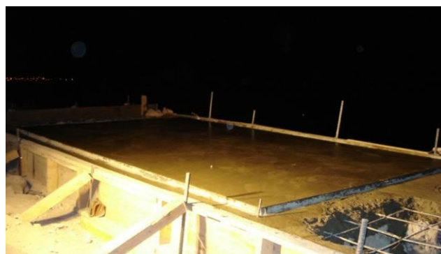
Figura 29. Colado de base de caseta.
