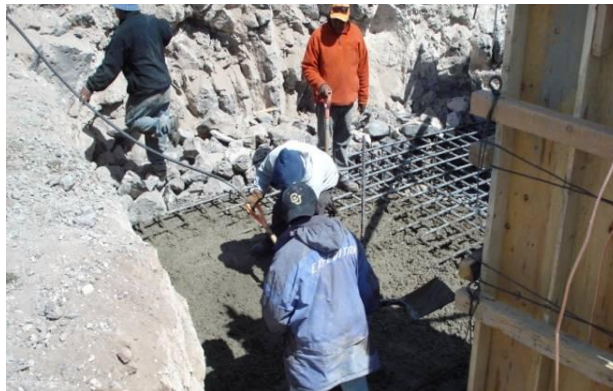
Figura 25. Colado de zapata.
