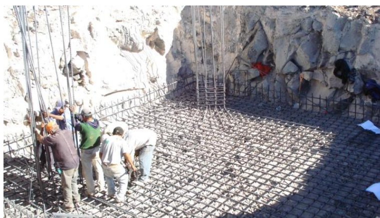
Figura 22 Colocación del acero para base de torre.
