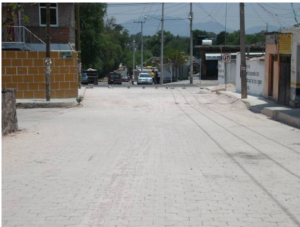
COLOCACION DE ADOQUIN EN CALLE EUCALIPTO
