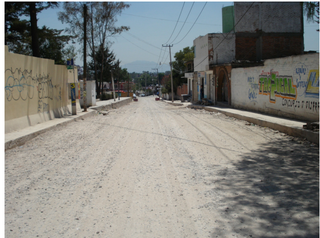
COLOCACION DE BASE HIDRAULICA EN CALLE EUCALIPTO
