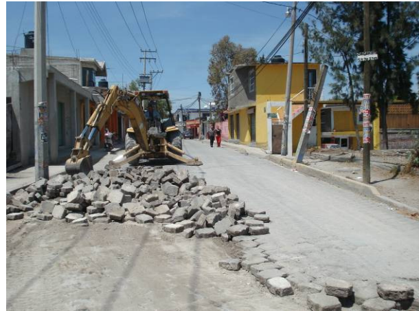
DEMOLICION DE ADOQUIN EN CALLE EUCALIPTO
