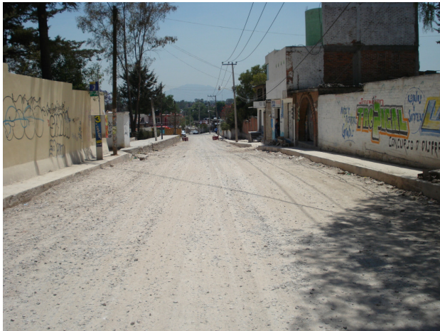
COLOCACION DE BASE HIDRAULICA EN CALLE EUCALIPTO
