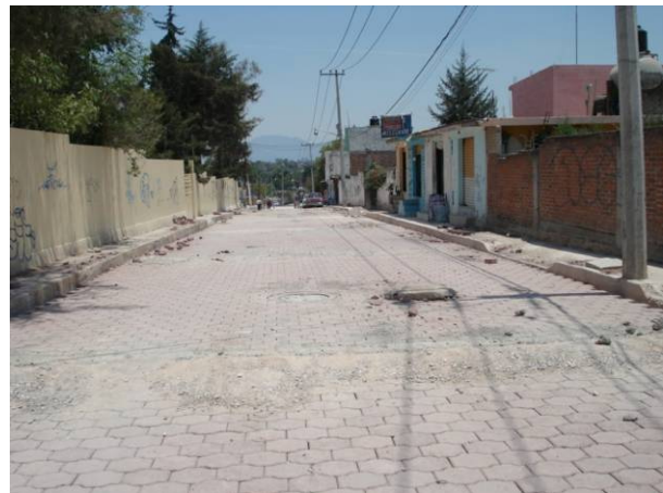
COLOCACION DE ADOQUIN EN CALLE EUCALIPTO
