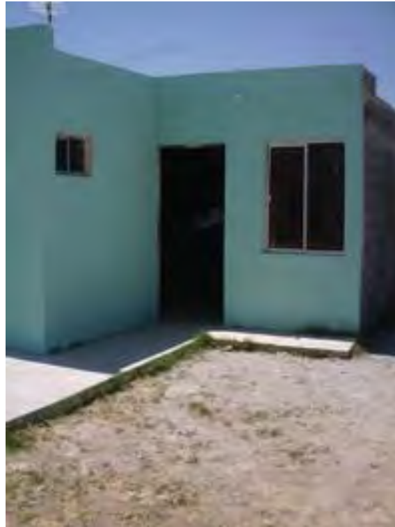
Ilustración 58 Unidad básica de vivienda (UBV): La vivienda que cuenta con un área mínima de construcción de 21 m 2 , con una altura mínima interior de 2.40 m, y con un volumen mínimo de 50.40 m 3 .
