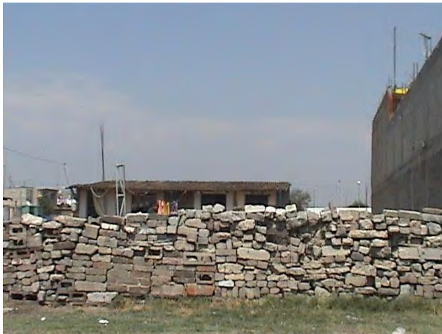
Ilustración 53. Calle Tezozómoc. Esta es una imagen representativa de la colonia, en ella se muestra la problemática existente, aunque la densidad de población y vivienda es baja obedece precisamente a la precariedad de las condiciones, además de esos factores aquí deben enfrentar a la inseguridad social y al pillaje entre vecinos.
