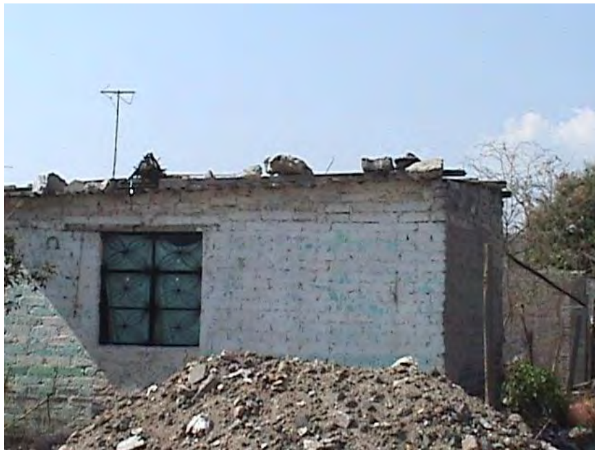
Ilustración 49. Calle Charrúas. En la colonia predominan las viviendas unifamiliares, construidas a base de materiales ligeros, en algunos casos: muros de tabique a flor de tierra, techos con materiales ligeros y precarios. La conformación de cada una de las construcciones es el diagnóstico del progreso familiar, de las necesidades y del trabajo por hacer entre el gobierno, instituciones y las familias.
