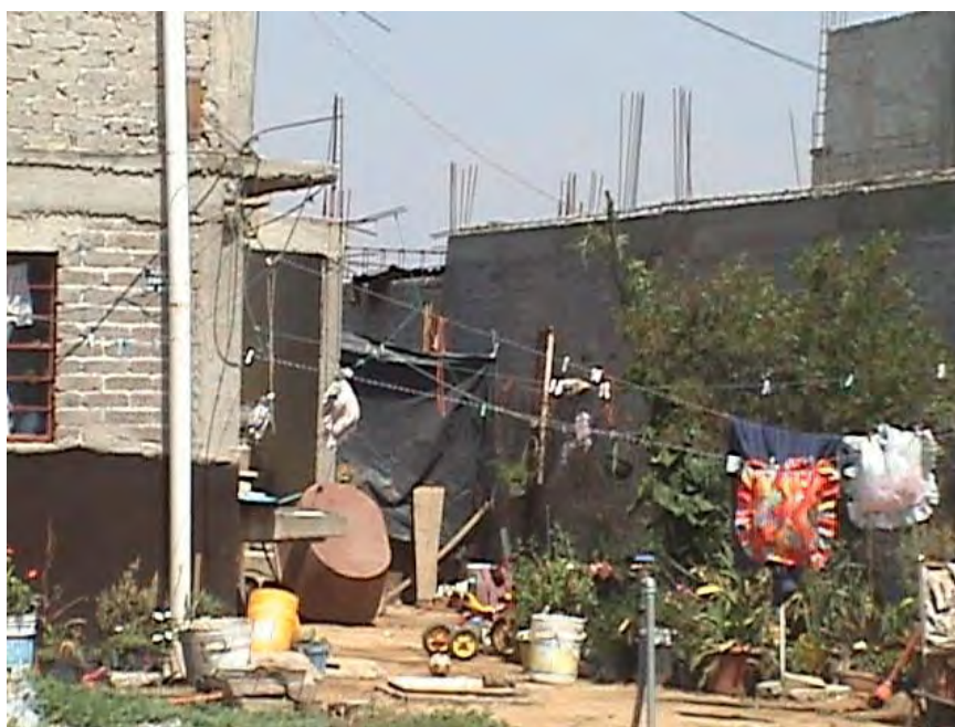
Ilustración 52. Calle Charrúas. En una etapa de desarrollo constructivo superior, algunas viviendas ya presentan un avance como patrimonio familiar, sin embargo aún queda mucho por hacer. Esta vivienda es un ejemplo de la necesidad de mejoramiento habitacional pues es evidente que requiere de bardas perimetrales, pisos en el patio, acabados y pintura en las fachadas, y puerta principal.
