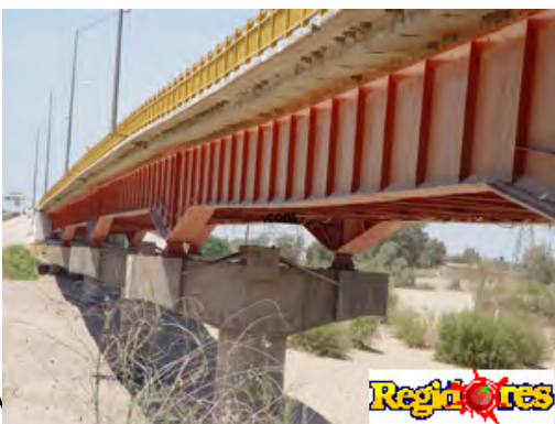
Vista del puente que cruza el Río Colorado conectando a Sonora con Baja California 96 .
