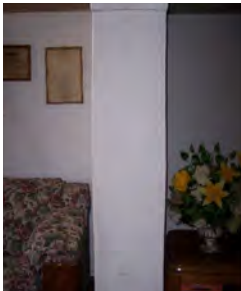
Muro de adobe de 32cm de ancho 89
