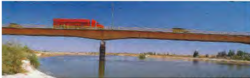
Imagen del puente que atraviesa en río Colorado 74
