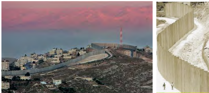
Dos vistas del muro en Israel 122
