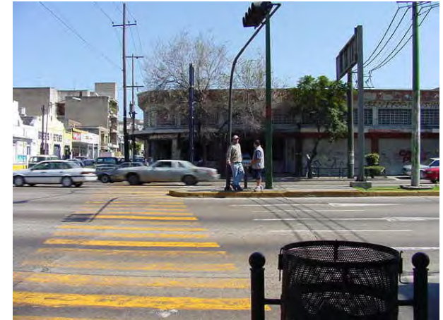
Sistema de energía eléctrica y señalización.
