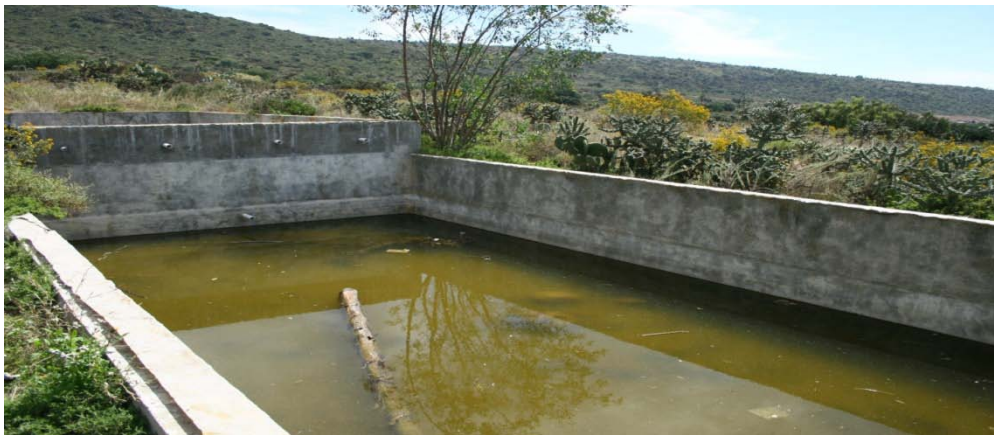
FIGURA 5: Depósito artificial contaminado con residuos sólidos y sin mantenimiento.
