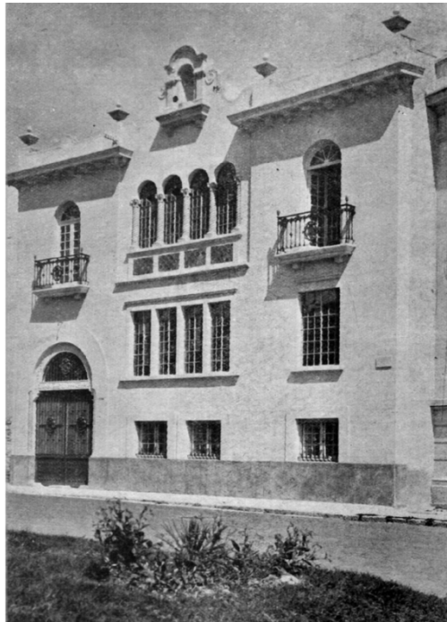
Imagen 29, fachada de la casa ubicada en Paseo de la Reforma 336, toda la estructura y sus divisiones fueron realizadas en concreto. Realizada en su totalidad con concreto armado en 1927.
