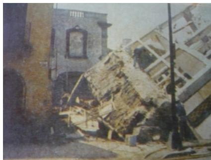
Imagen 39, durante los sismos de 1985 la colonia Roma fue una de las más afectadas, el edificio contiguo a la casa de Orizaba 146 se colapsó por completo, la casa no sufrió mayores daños. Imagen obtenida del libro "Experiencias derivadas de los sismos de 1985". Fundacion ICA A.C., México, 1987.
