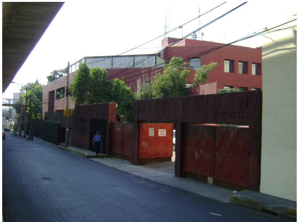
Foto - 1 Panorámicas de la fachada principal y del sitio de estudio
