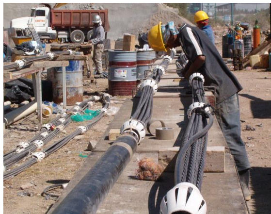
Foto – 16 Tensión y longitud de anclas
