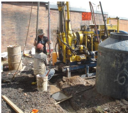
Foto - 9 Equipo de perforación y ejecución de sondeos profundos.
