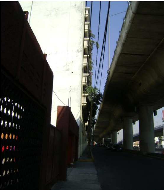
Av. Anillo Periférico, por donde se encuentra el acceso al predio.
