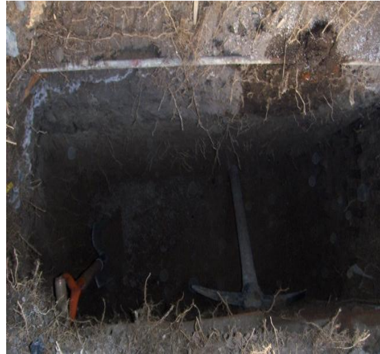
Excavación del pozo terminada, en donde se realiza el muestreo de cada estrato de suelo que hay en el lugar de la excavación.
