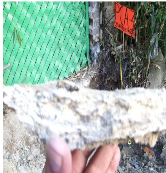
Carbonato de calcio obtenido de la excavación, la capa tiene un espesor aproximado de 15cm.
