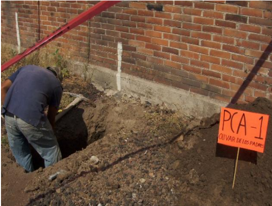
Avance en la excavación del pozo a cielo abierto número 1.
