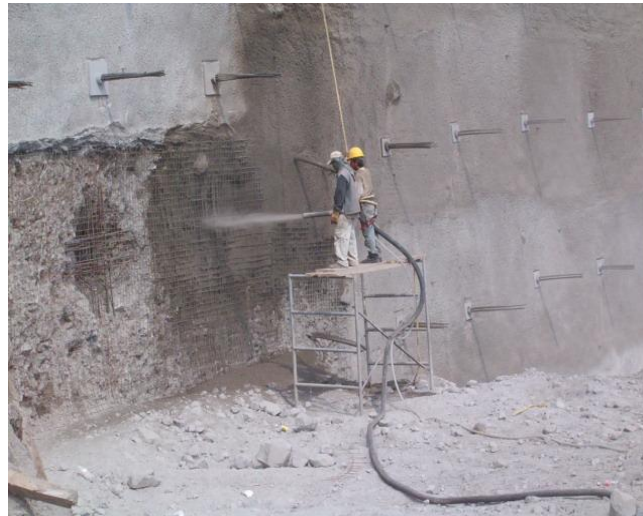
Foto – 22 Lanzado de concreto lanzado
