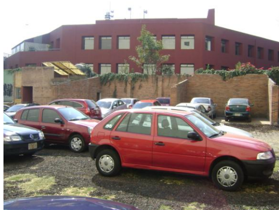
Imagen capturada desde el interior del predio, hacia la edificación existente al sur, la cual es una construcción de 3 niveles y un sótano.
