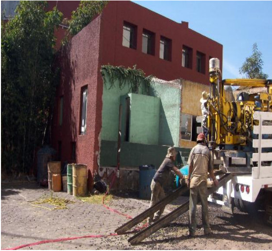
Llegada del equipo de perforación, para realizar los Sondeos de Penetración Estándar.
