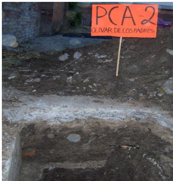
Imagen en la cual se aprecia la cimentación del muro que delimita el predio, la cual consta de una zapata corrida.
