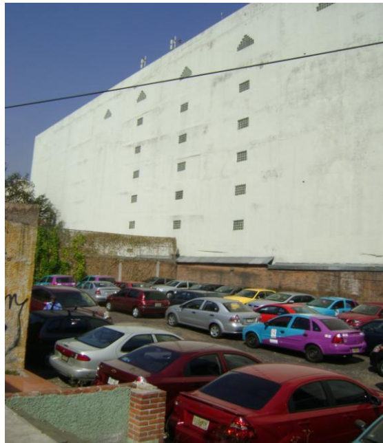
Imagen en la cual se aprecia la construcción existente de 7 niveles, al norte del predio y que funciona en su totalidad como estacionamiento (Televisa).
