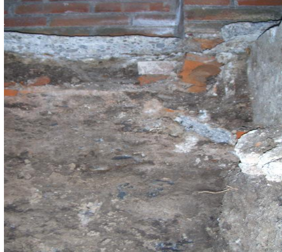
Losa de concreto de aproximadamente 10cm de espesor, subyaciendo una capa de relleno constituida con arcilla y pedacería de ladrillo rojo.
