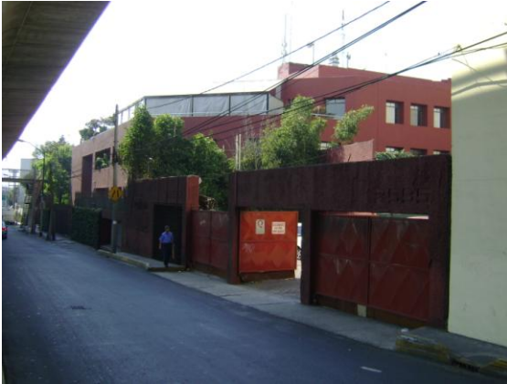
Acceso principal del predio en estudio, ubicado en el Periférico Sur No. 2595.
