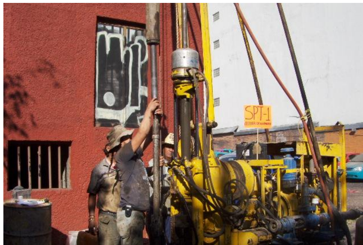
Figura - 9 Registro De Campo Del Spt-1
