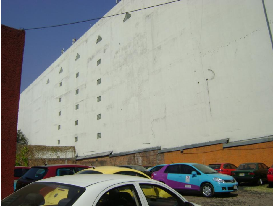
Foto - 5 Estructura de 7 niveles localizada sobre colindancia norte
