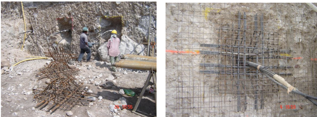
FIGURA 24. LABRADO DE CAJA PARA ALOJAR ZAPATA DEL ANCLA Y COLOCACIÓN DE REFUERZO
