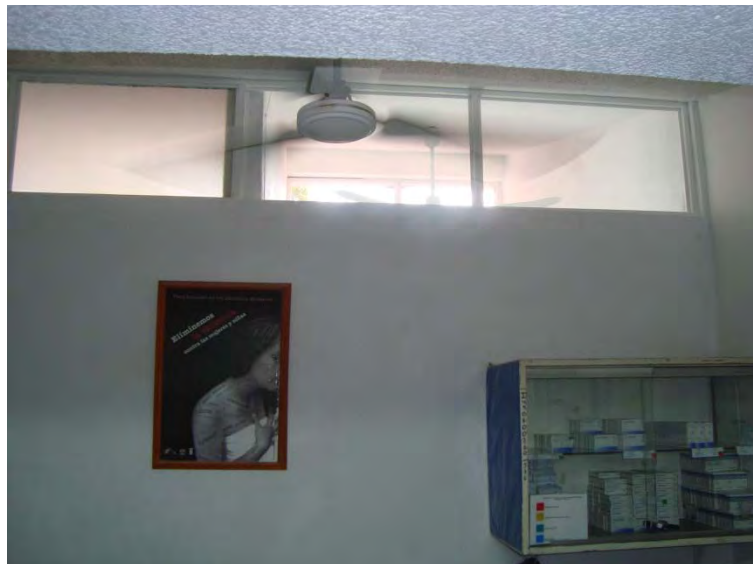
Condiciones de iluminación y ventilación en uno de los consultorios.
