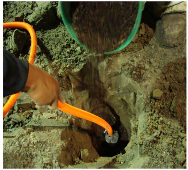
Foto 4.- Colocación de filtro para piezómetro
